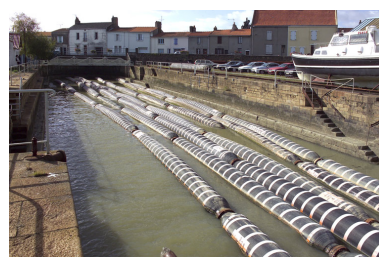
Vue partielle du quai Albert- Chassagne depuis la cale. Phot. Denis Pillet IVR52_20044401896NUCA
