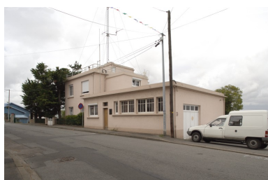
Bureaux du Port autonome, quai Libert. Phot. François Lasa IVR52_20054401136NUCA
