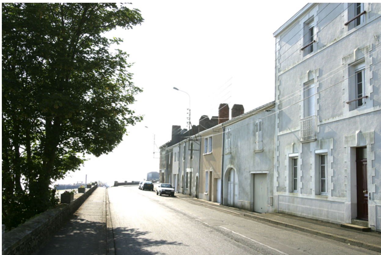
49 à 43, quai Chassagne.
