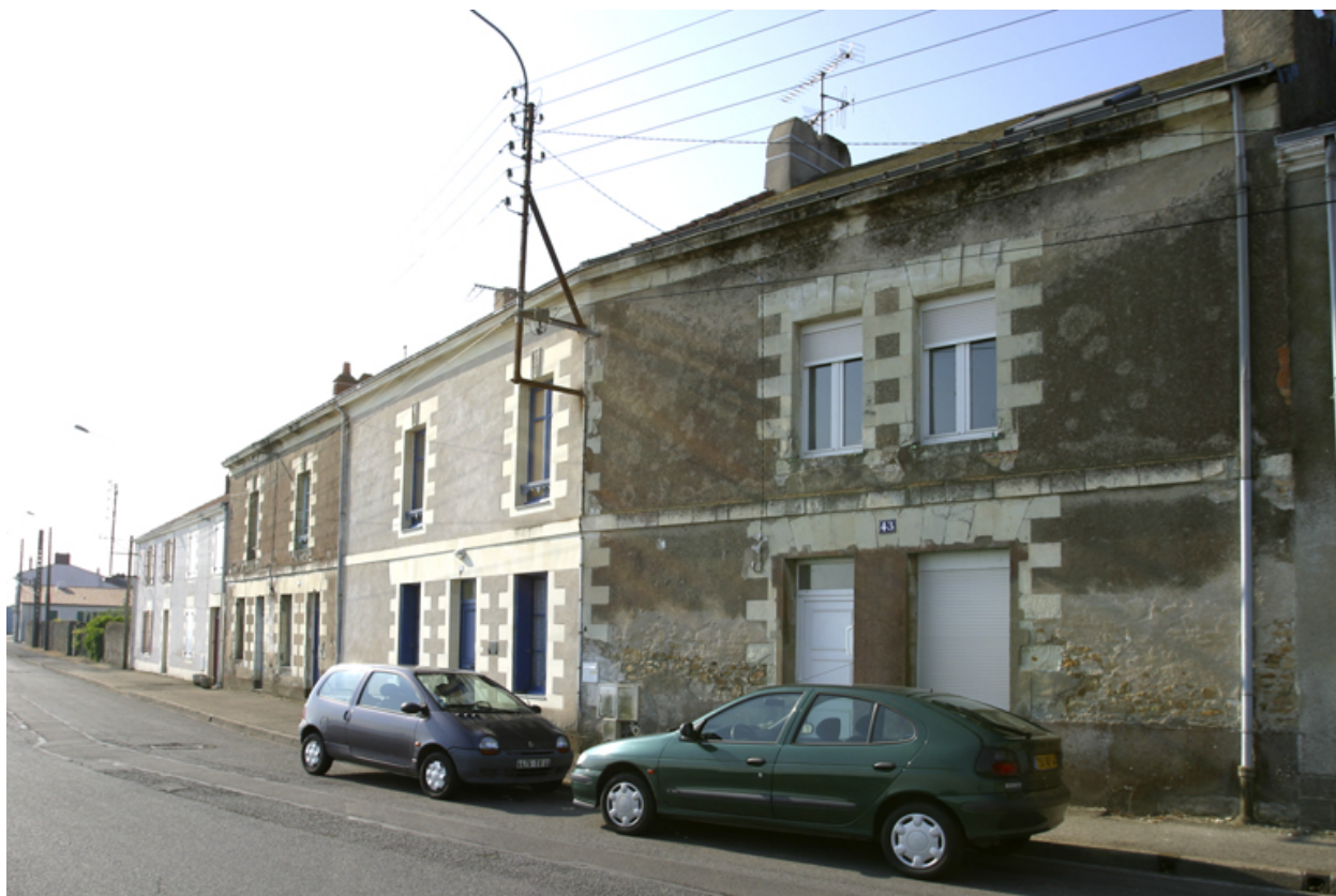
43 à 40, quai Chassagne.
