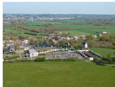
Vue aérienne du cimetière depuis le sud. Phot. Armelle Maugin IVR52_20254900417NUCA
