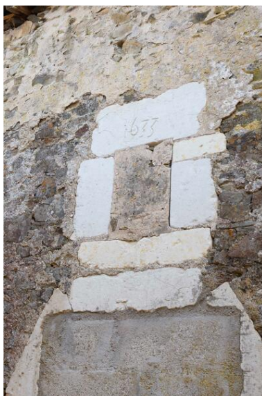
10 rue des Mauges. Vestige d'un jour daté 1633. Phot. Armelle Maugin IVR52_20254900406NUCA
