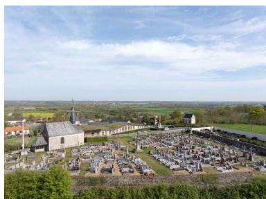
Vue aérienne du cimetière depuis le sud. Phot. Armelle Maugin IVR52_20254900411NUCA
