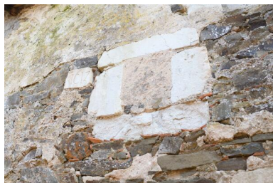
10 rue des Mauges. Détail d'un bloc de tuffeau (en remploi ?) daté 1613. Phot. Armelle Maugin IVR52_20254900405NUCA
