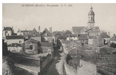
Le bourg du Mesnil. Vue depuis l'est. Carte postale. 1er quart 20e siècle. (Coll. part.). Repro. Armelle Maugin IVR52_20244901140NUCA
