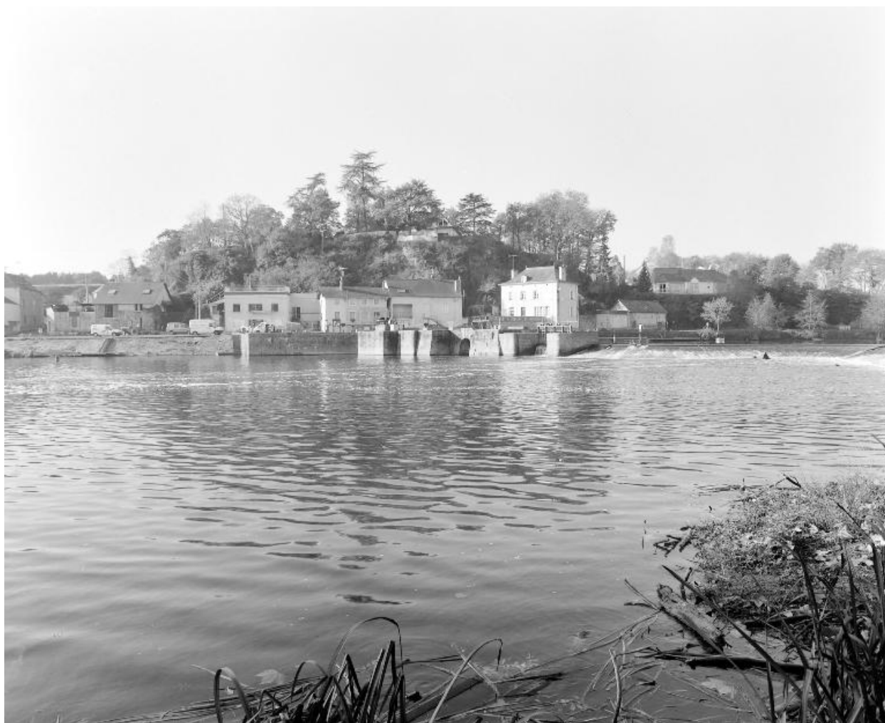
Vue du site depuis la rive gauche : au centre le soubassement du moulin détruit et le coursier du large ; derrière, la maison éclésièrre et la maison du meunier à toiture à croupes.
