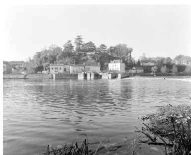
Vue du site depuis la rive gauche : au centre le soubassement du moulin détruit et le coursier du large ; derrière, la maison éclusière et la maison du meunier à toiture à croupes.
