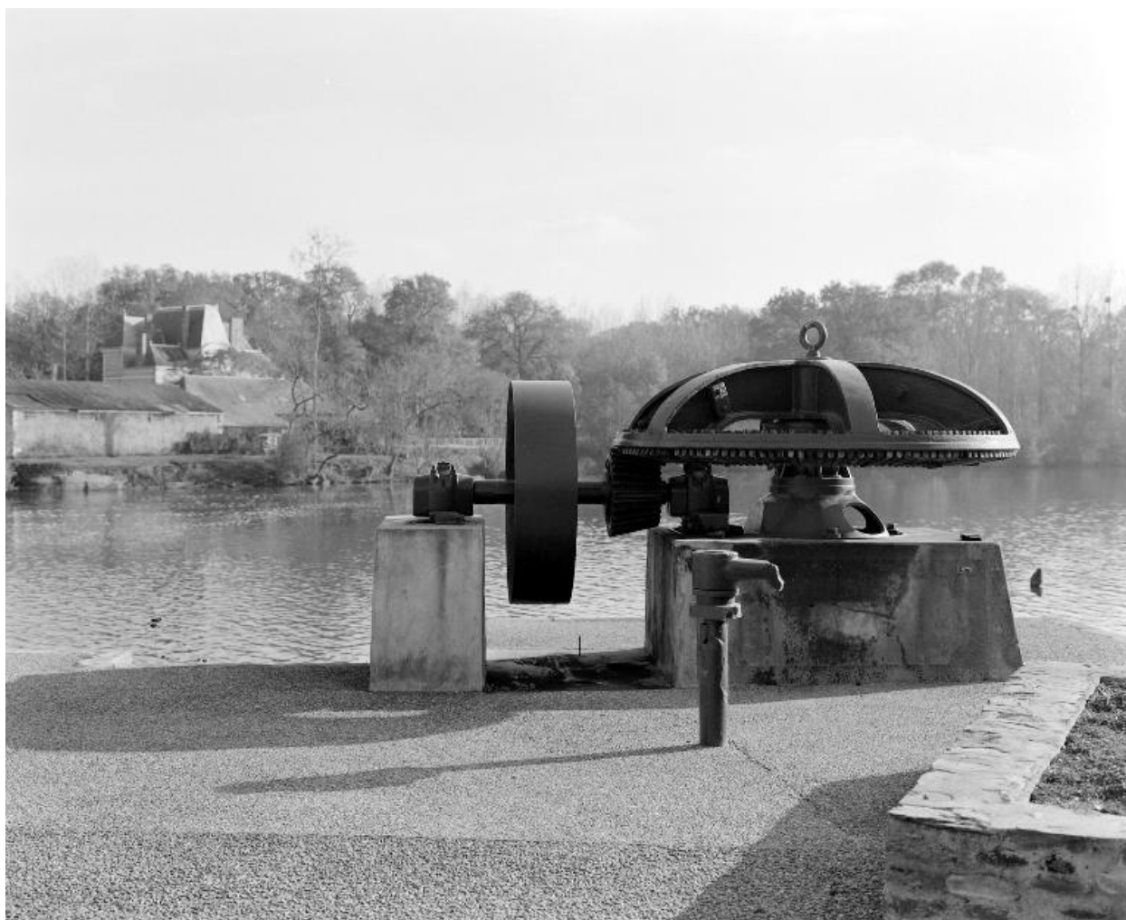
La roue et le pignon servant à la transmission de l'énergie hydraulique produite par la turbine de rive.
