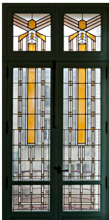
Verrière de la porte-fenêtre du bureau est.
