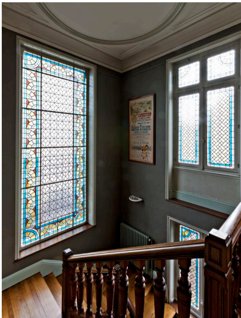
Vue d'ensemble des 3 verrières de l'escalier depuis le palier.
