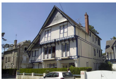
Vue d'ensemble de la villa Laus Deo. Phot. Denis Pillet IVR52_20044400585NUCA
