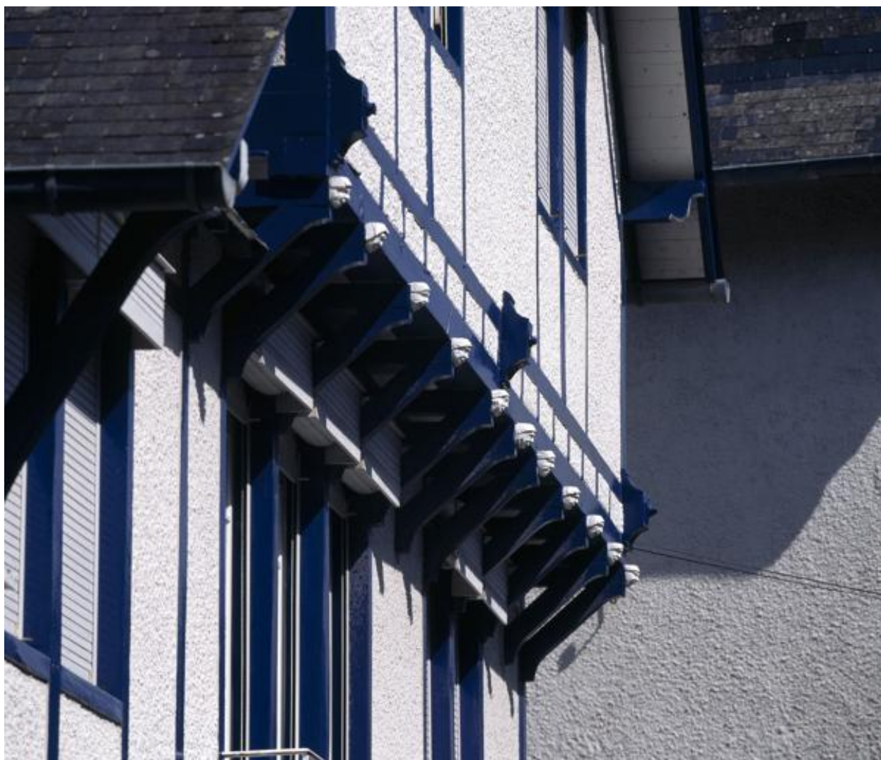
Détail de l'encorbellement et des têtes d'hommes aux abouts de poutre du 2e étage de la villa Laus Deo.
