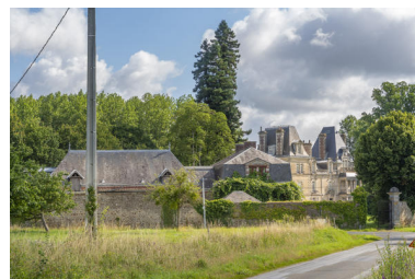
Une vue d'ensemble depuis l'ouest. Phot. Pierre-Bernard Fourny IVR52_20215300980NUCA
