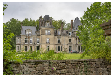
Le château. Phot. Pierre-Bernard Fourny IVR52_20215301046NUCA
