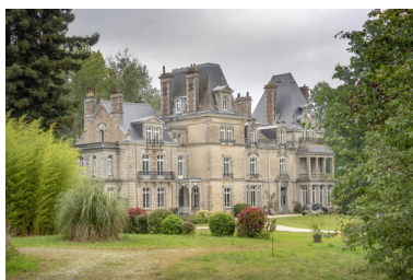
Le château. Phot. Pierre-Bernard Fourny IVR52_20215301044NUCA
