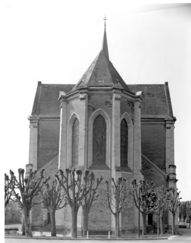
Le chevet vu depuis le nord-est. Phot. Jacques Le Callonnec IVR52_19805300187V
