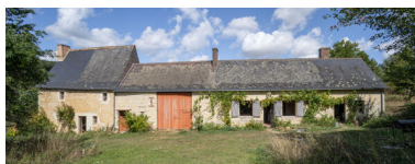
Vue frontale, de gauche à droite : logis à étage, grange-étable, logis en rez-de-chaussée, fournil. Phot. Jeanne Minier IVR52_20257200463NUCA
