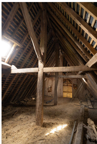
Logis à étage : charpente. Phot. Jeanne Minier IVR52_20257200466NUCA
