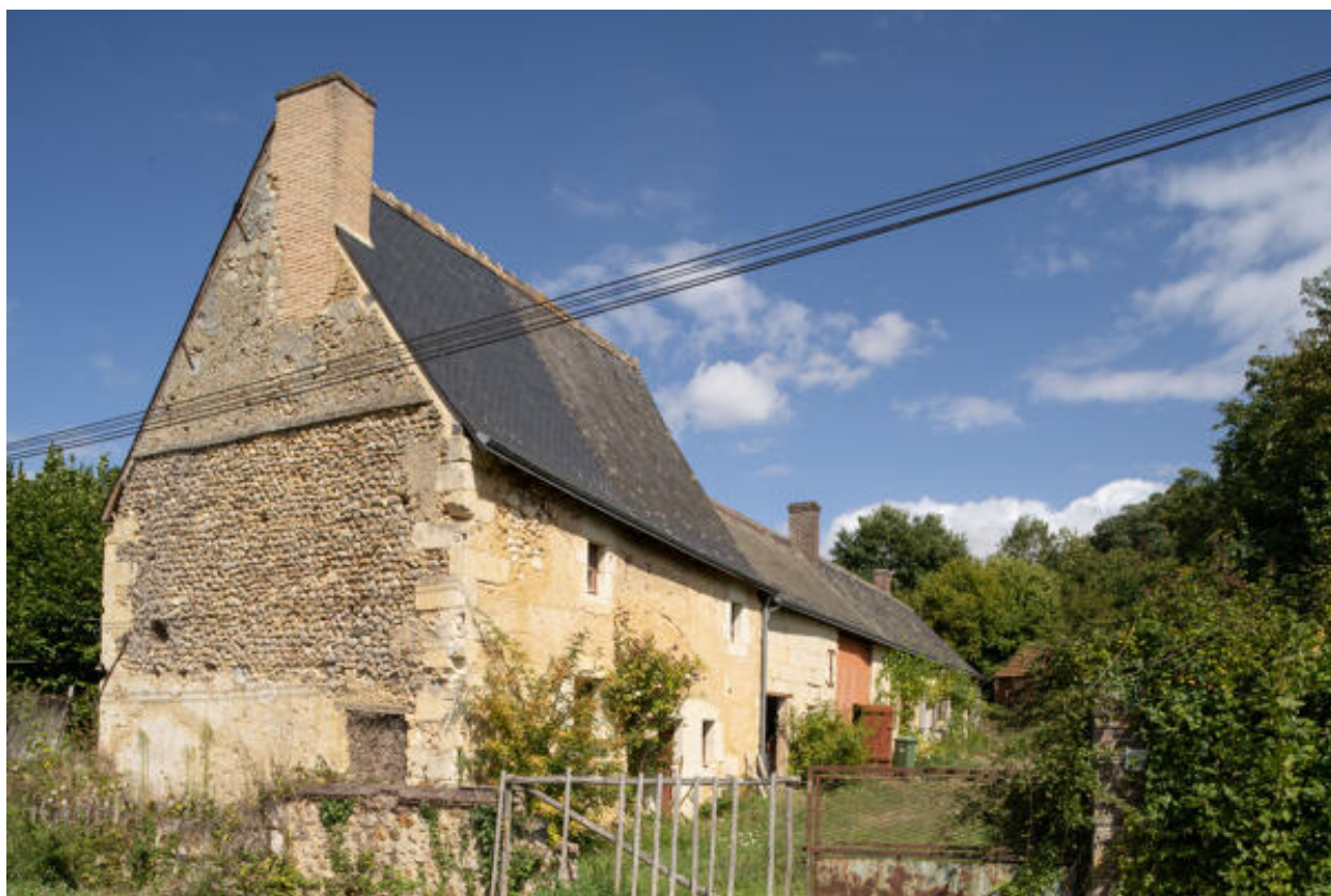
Vue d'ensemble depuis la route de Tresson, avec le logis à étage au premier plan.
