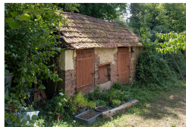
Toit à porcs. Phot. Jeanne Minier IVR52_20257200472NUCA
