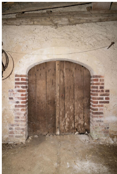
Cellier : porte. Phot. Jeanne Minier IVR52_20257200469NUCA
