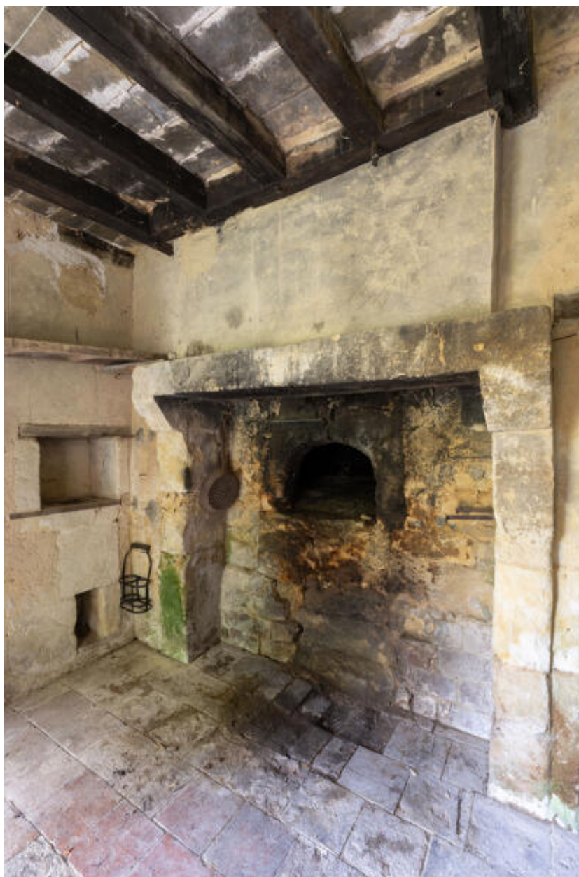
Le fournil : cheminée avec four à pain et potager.
