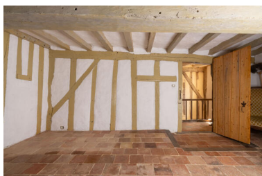
Logis à étage : cloison et mur en pan de bois à l'étage. Phot. Jeanne Minier IVR52_20257200465NUCA
