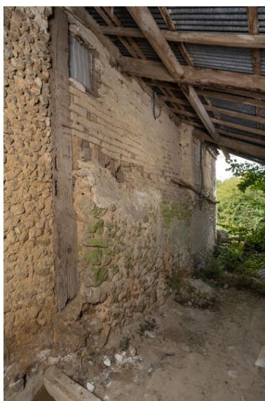
Arrière du logis à étage : pan de bois. Phot. Jeanne Minier IVR52_20257200468NUCA
