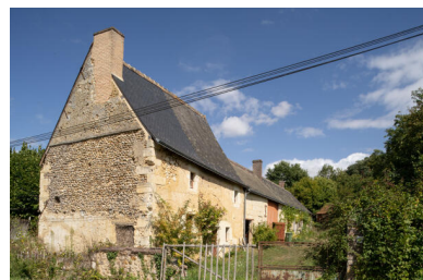
Vue d'ensemble depuis la route de Tresson, avec le logis à étage au premier plan. Phot. Jeanne Minier IVR52_20257200461NUCA
