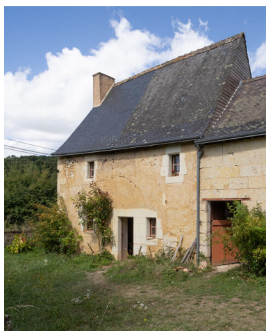
Le logis à étage. Phot. Jeanne Minier IVR52_20257200462NUCA
