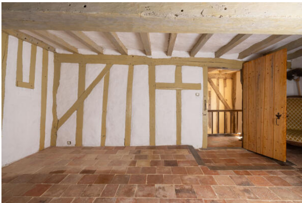
Logis à étage : cloison et mur en pan de bois à l'étage.
