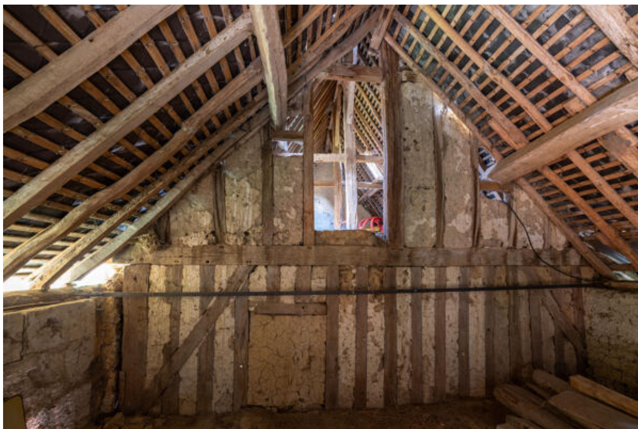
Logis à étage : pignon en pan de bois.
