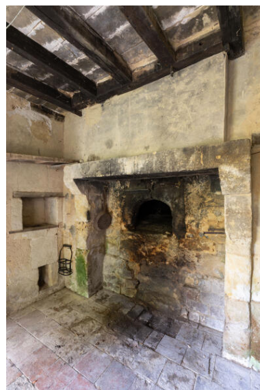
Le fournil : cheminée avec four à pain et potager. Phot. Jeanne Minier IVR52_20257200471NUCA
