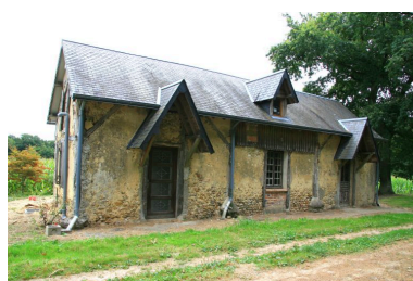
Vue de volume : maison en pan de bois avec des auvents au-dessus des portes. Phot. Jean-Baptiste Darrasse IVR52_20087202003NUCA
