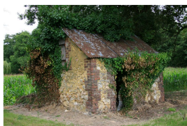
Petite dépendance : toits à porcs avec chaînage de briques. Phot. Jean-Baptiste Darrasse IVR52_20087202006NUCA
