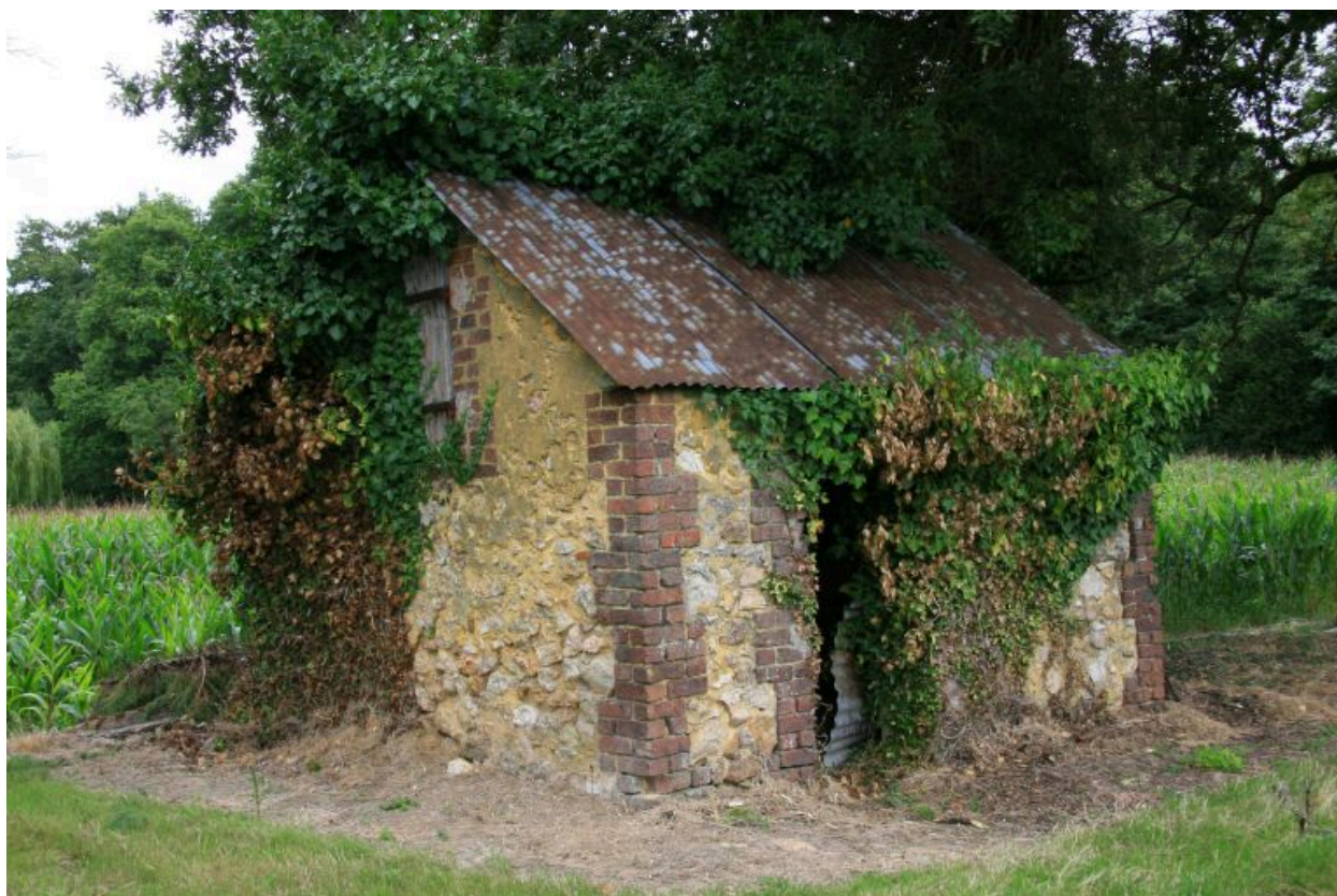
Petite dépendance : toits à porcs avec chaînage de briques.
