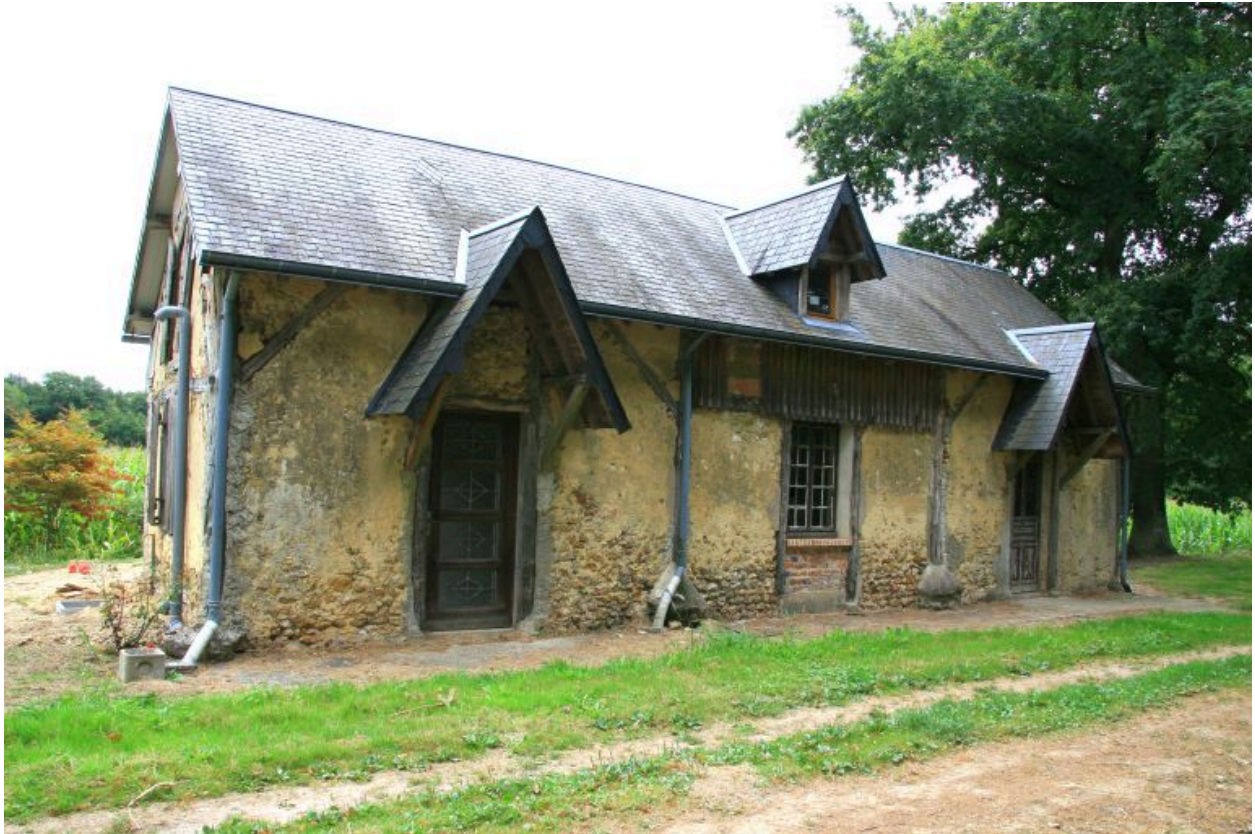
Vue de volume : maison en pan de bois avec des auvents au-dessus des portes.
