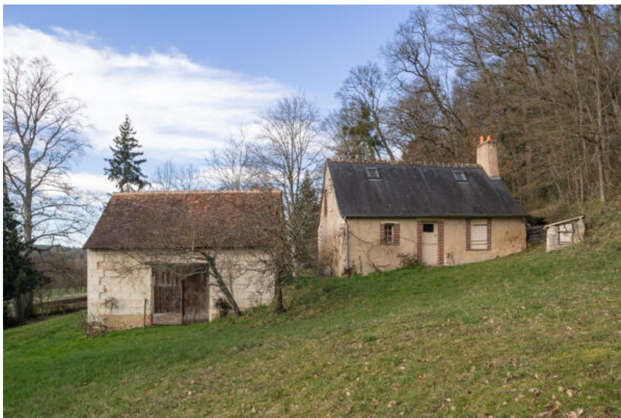
Logement et grange de la Cave Boutin.
