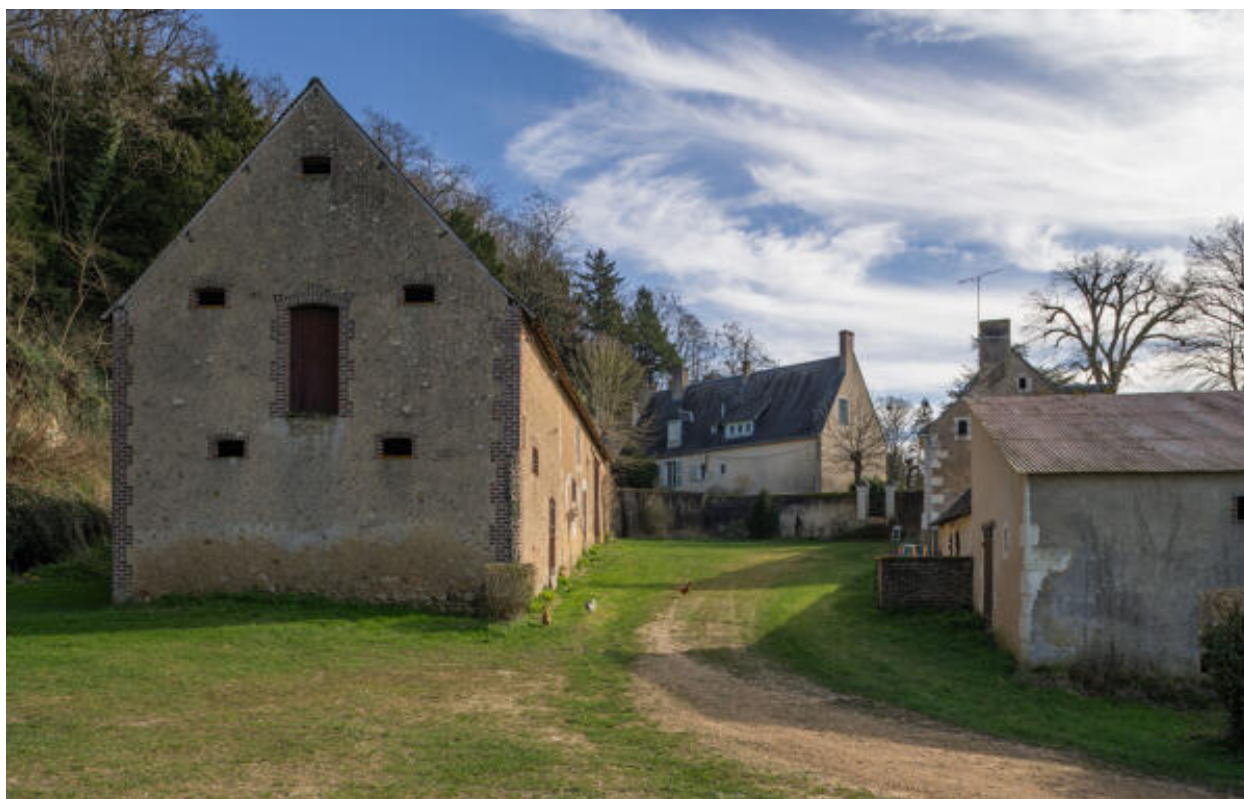
La ferme : vue d'ensemble.
