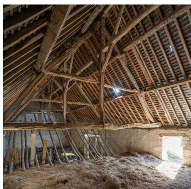
Grange-étable : charpente. Phot. Jeanne Minier IVR52_20267200258NUCA
