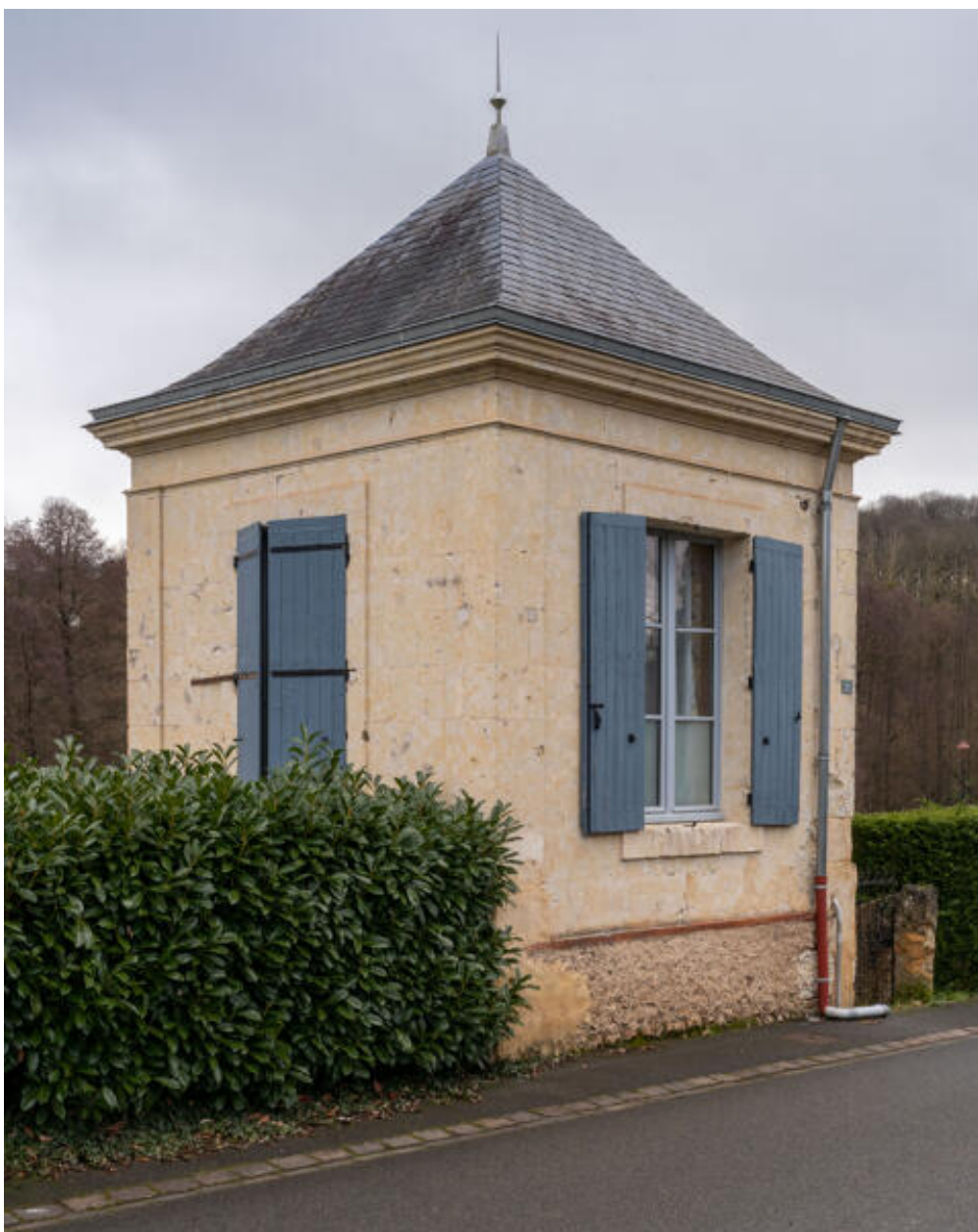
Fabrique de jardin, rue Neuve.
