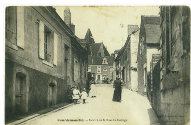
La rue du Collège : carte postale ancienne, début XXe siècle. IVR52_20237200785NUCA
