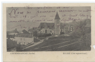
Le centre du village de Courdemanche : carte postale ancienne, début XXe siècle. IVR52_20237200777NUCA
