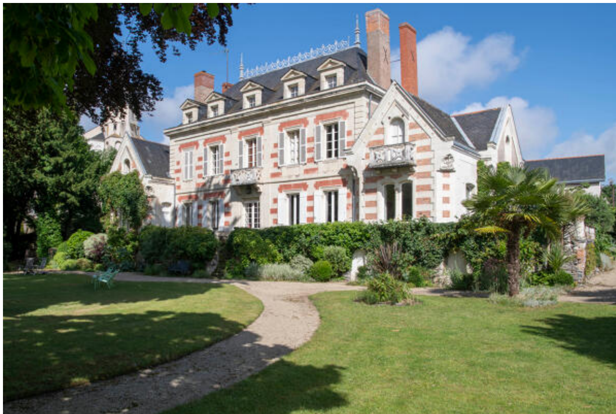
Vue de la façade postérieure en brique et tuffeau.
