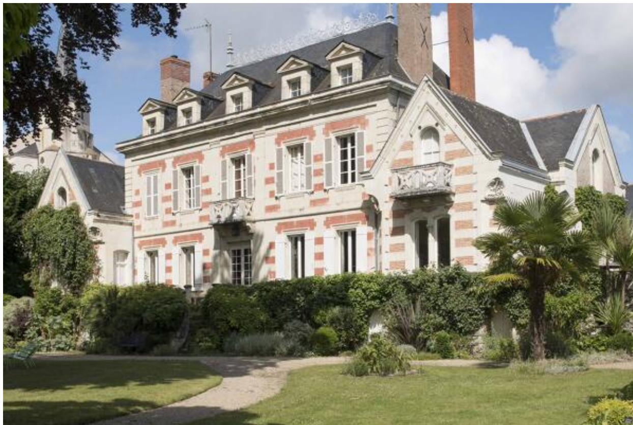
Vue de la façade postérieure depuis le jardin.
