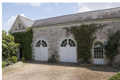
Communs en moellons de schiste. Phot. Armelle Maugin IVR52_20194900231NUCA
