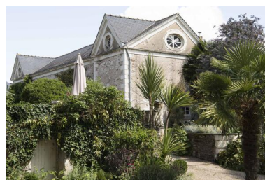
Communs en moellons de schiste. Phot. Armelle Maugin IVR52_20194900230NUCA
