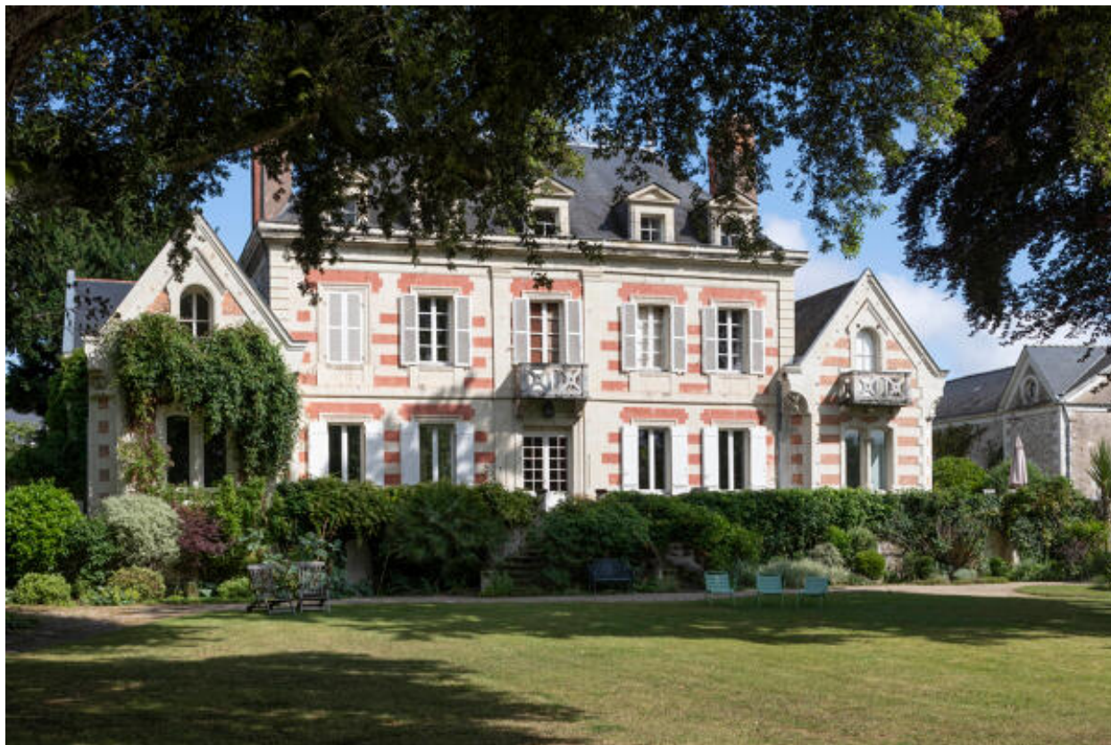
Façade postérieure et ses deux pavillons ouverts d'une baie géminée au rez-de-chaussée et d'une fenêtre avec balcon à l'étage.
