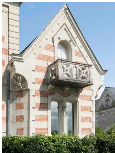
Pavillon de style néogothique en brique et tuffeau. Phot. Armelle Maugin IVR52_20194900228NUCA
