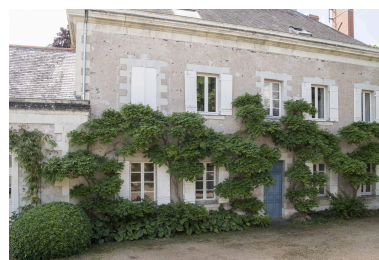
Communs en moellons de schiste. Phot. Armelle Maugin IVR52_20194900232NUCA
