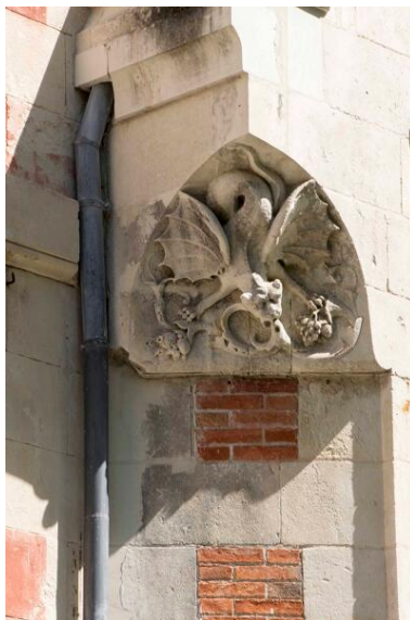
Amortissement ornée d'un bestiaire médiéval dans les angles des pavillons. Dragon. Phot. Armelle Maugin IVR52_20194900222NUCA
