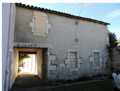
L'aile de communs entre la mairie et ses annexes, avec passage couvert, vue depuis le nord. Phot. Yannis Suire IVR52_20218500213NUCA
