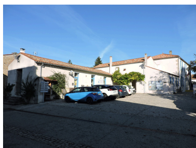
La mairie et ses annexes vues depuis le sud. Phot. Yannis Suire IVR52_20218500204NUCA
