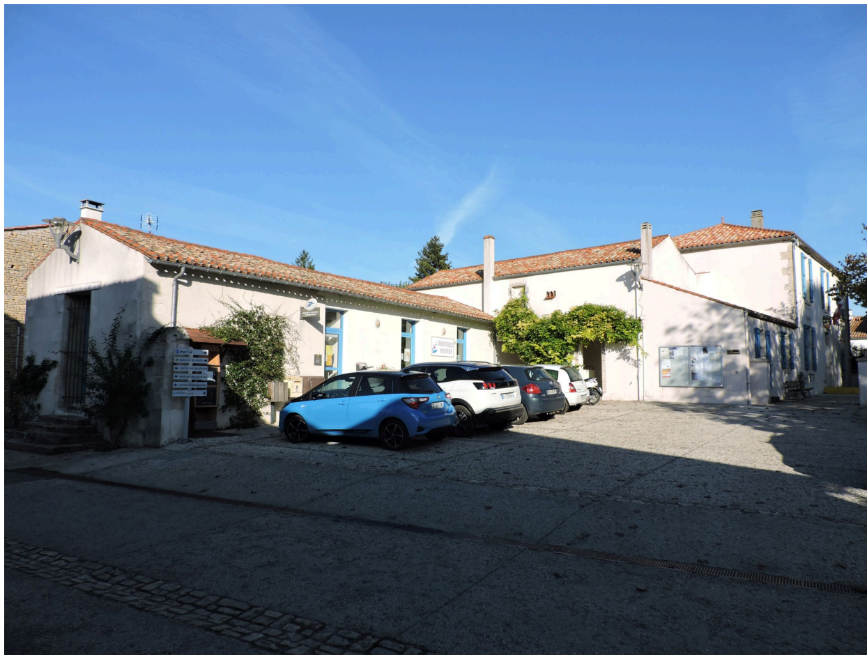
La mairie et ses annexes vues depuis le sud.
