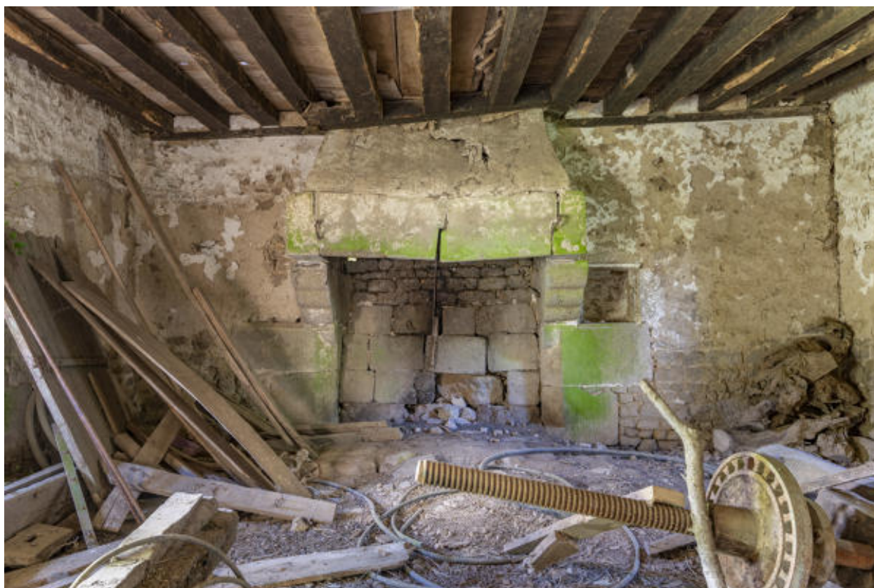
La cheminée du rez-de-chaussée.
