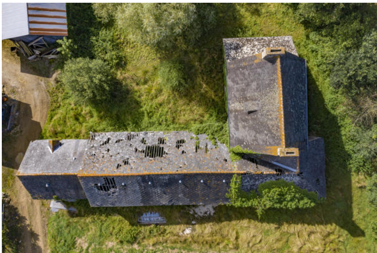
Une vue aérienne des toits du logis et des dépendances en retour.
