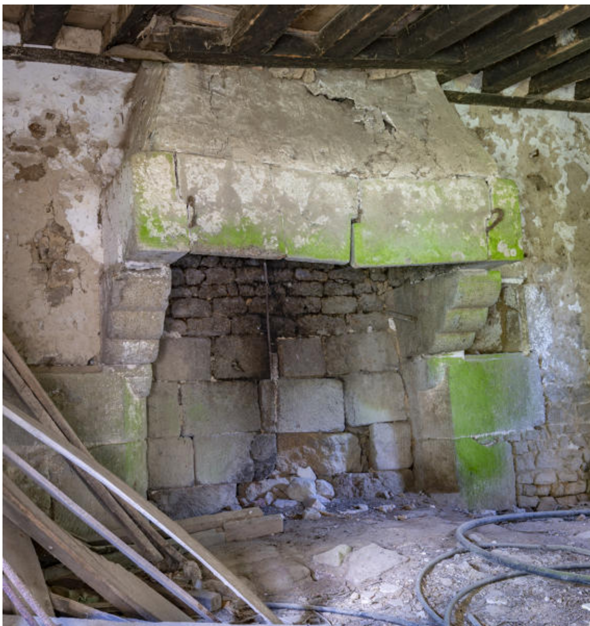
La cheminée du rez-de-chaussée.
