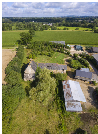
Une vue aérienne d'ensemble, depuis le sud-est. Phot. Pierre-Bernard Fourny IVR52_20215301025NUCA
