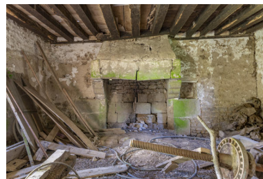
La cheminée du rez-de-chaussée. Phot. Pierre-Bernard Fourny IVR52_20215300986NUCA
