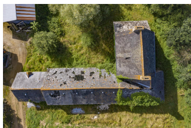
Une vue aérienne des toits du logis et des dépendances en retour. Phot. Pierre-Bernard Fourny IVR52_20215301022NUCA
