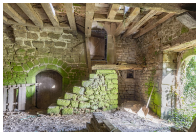
Un escalier et des portes vers les dépendances, au rez-de-chaussée du logis. Phot. Pierre-Bernard Fourny IVR52_20215300983NUCA
