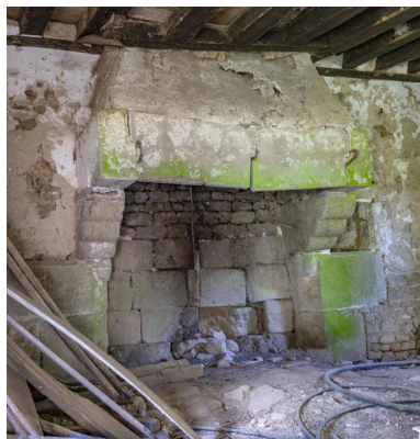
La cheminée du rez-de-chaussée. Phot. Pierre-Bernard Fourny IVR52_20215300985NUCA
