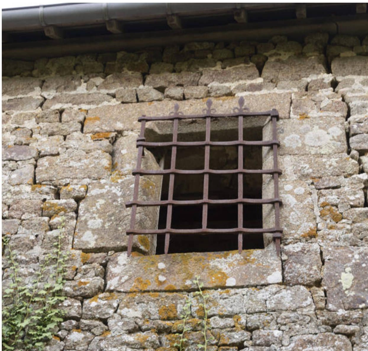
Une baie chanfreinée à grille de la façade postérieure du logis.
