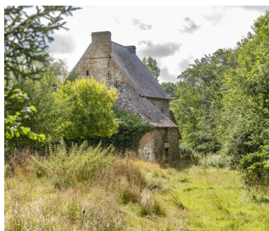
L'ancien chemin longeant la façade postérieure du manoir. Phot. Pierre-Bernard Fourny IVR52_20215300982NUCA
