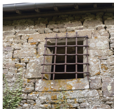
Une baie chanfreinée à grille de la façade postérieure du logis. Phot. Pierre-Bernard Fourny IVR52_20215300987NUCA
