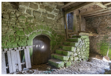
Un escalier et des portes vers les dépendances, au rez-de-chaussée du logis. Phot. Pierre-Bernard Fourny IVR52_20215300984NUCA
