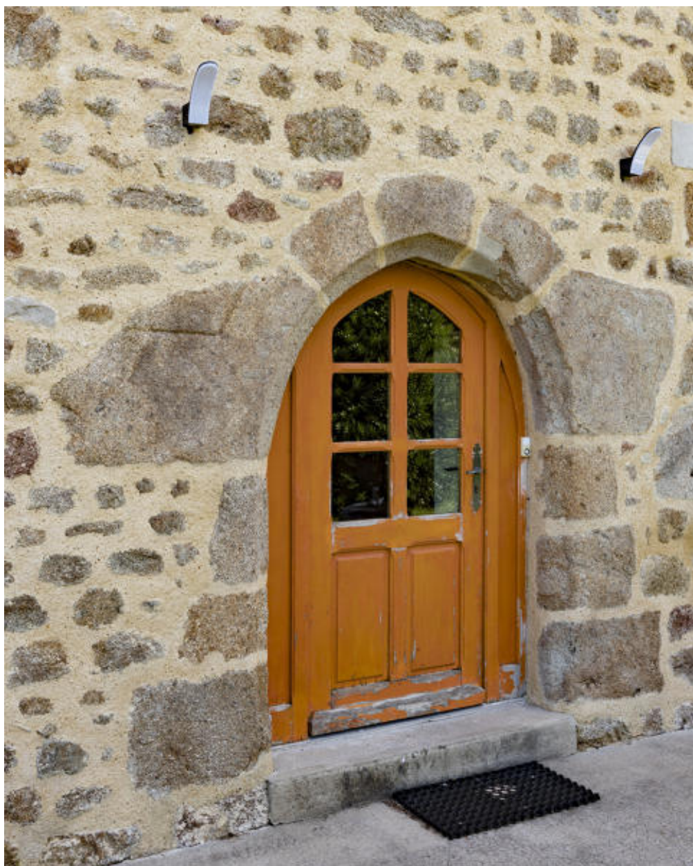
La porte brisée d'un bâtiment remanié face au logis.
