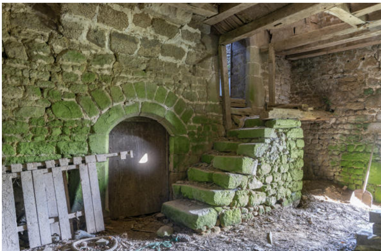
Un escalier et des portes vers les dépendances, au rez-de-chaussée du logis.
