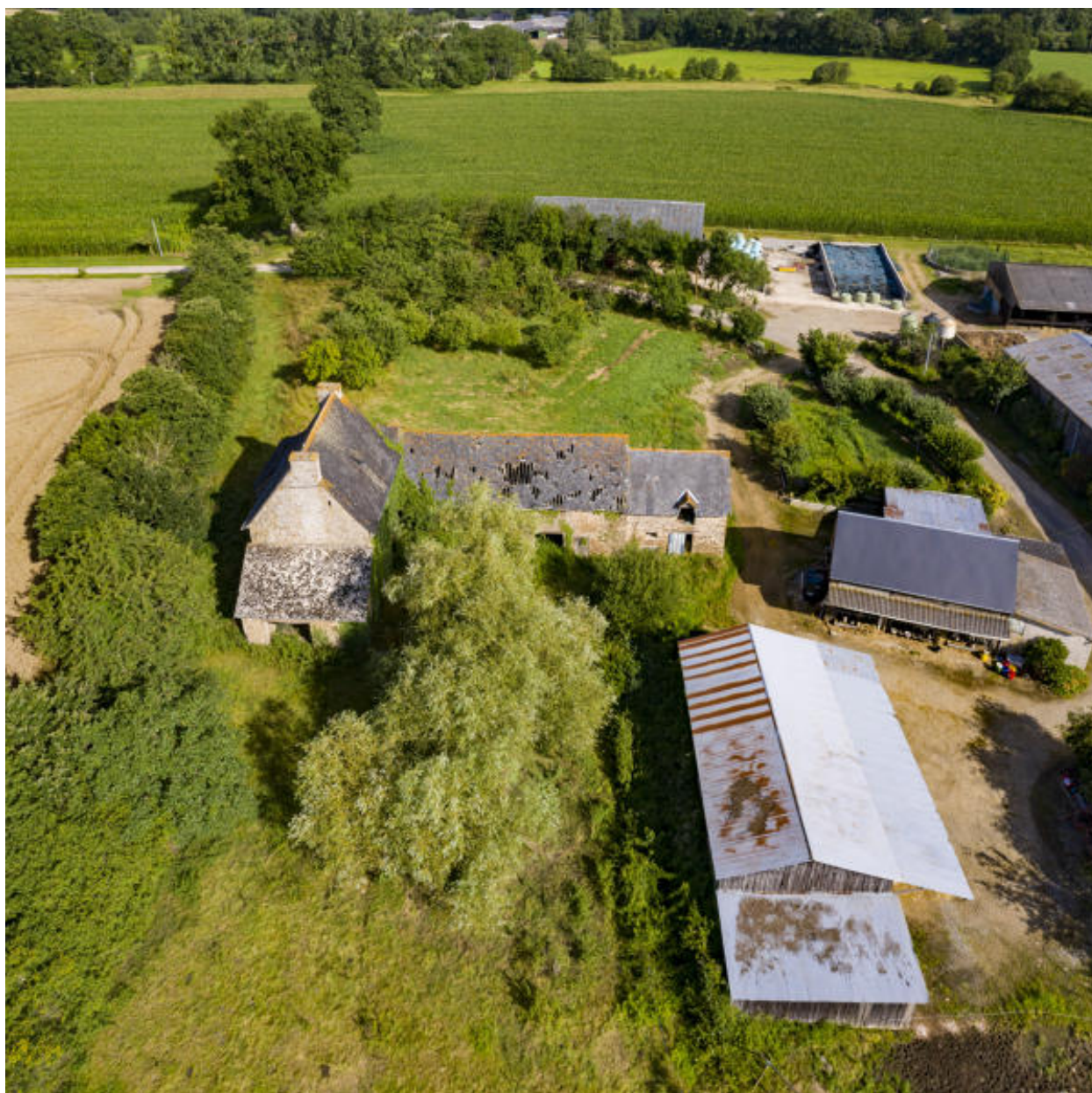
Une vue aérienne d'ensemble, depuis le sud-est.
