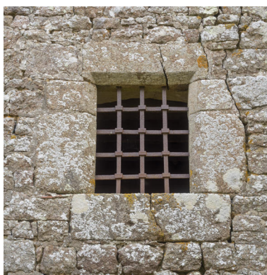
Une baie chanfreinée à grille de la façade postérieure du logis. Phot. Pierre-Bernard Fourny IVR52_20215300988NUCA
