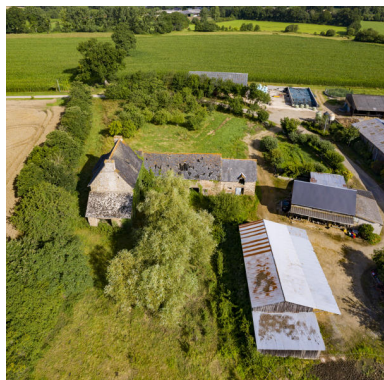
Une vue aérienne d'ensemble, depuis le sud-est. Phot. Pierre-Bernard Fourny IVR52_20215301024NUCA
