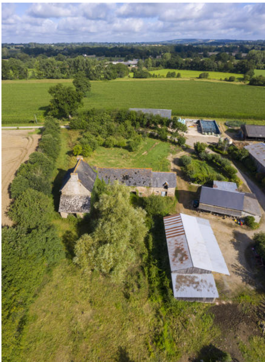
Une vue aérienne d'ensemble, depuis le sud-est.
