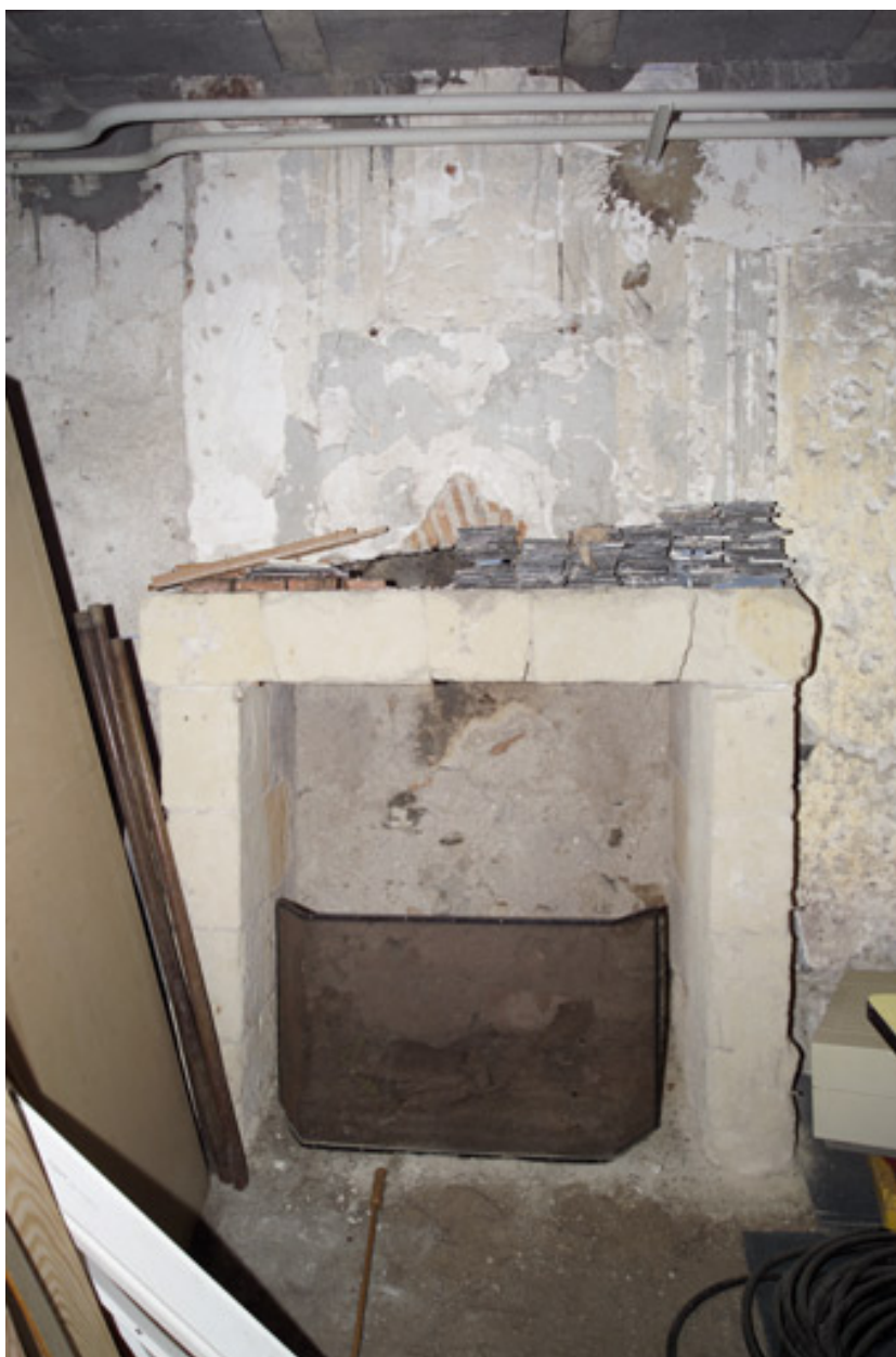
Niveau de soubassement, le pignon ouest, la cheminée de la première maison.
