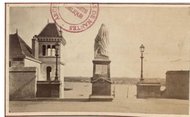
Construction de la maison, vue de l'avenue Sainte-Anne, 1878. Phot. Patrick (reproduction) Jean IVR52_20134401200NUCA
