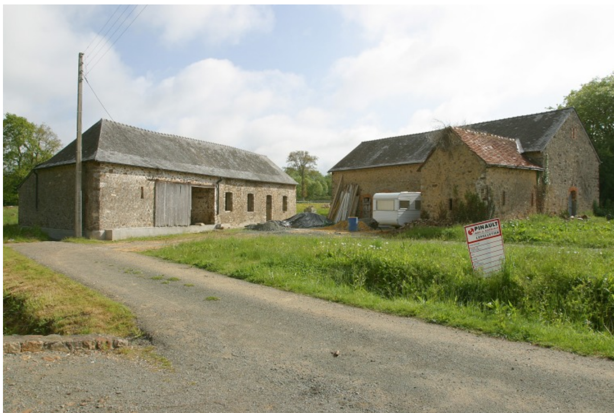
Vue d'ensemble depuis le sud : l'ancien logis-étable, l'étable-porcherie.
