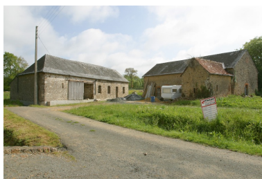
Vue d'ensemble depuis le sud : l'ancien logis- étable, l'étable-porcherie. Phot. François Lasa IVR52_20035301706NUCA
