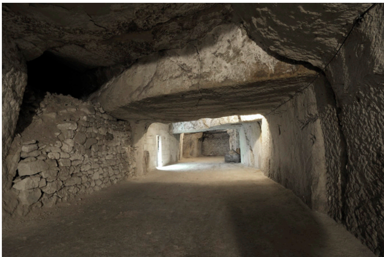
Cavité sud-est : galerie d'extraction du XIXe siècle (2).
