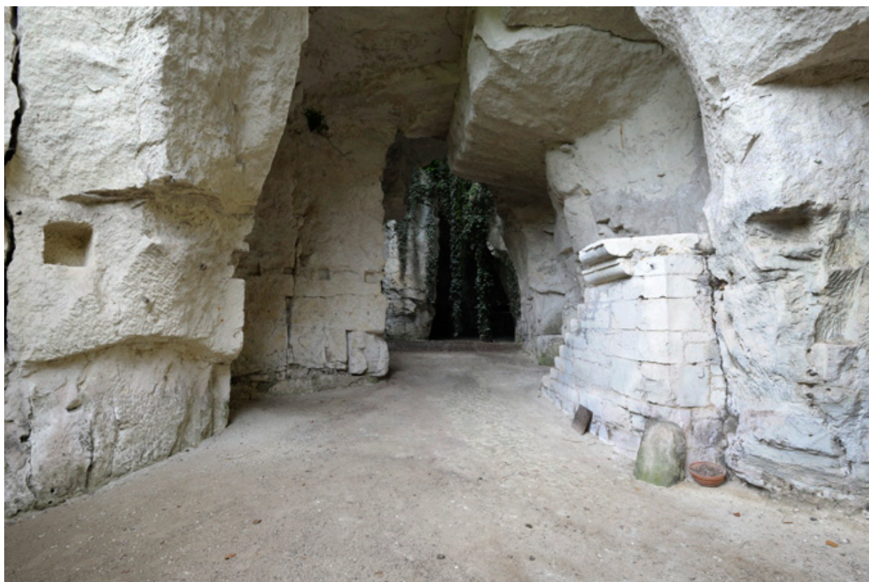
Seconde arche : traces des poutres et solives du plancher de l'entrepôt disparu auquel menait l'escalier.
