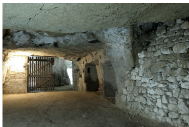
Cavité sud-est : entrée de la galerie d'extraction du XIXe siècle. Phot. Bruno Rousseau, Phot. Youenn Communeau IVR52_20124901349NUCA
