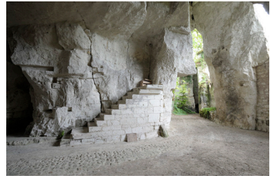
Seconde arche : escalier d'accès à un niveau de plancher de l'entrepôt disparu.
