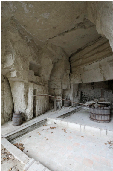
Premier fontis : cavité latérale, maies et pressoirs encore en place (à vis et cage) ou sous forme de traces (types : casse-cou et à roue).
