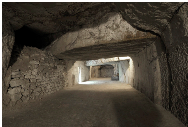
Cavité sud-est : galerie d'extraction du XIXe siècle (2). Phot. Bruno Rousseau, Phot. Youenn Communeau IVR52_20124901346NUCA
