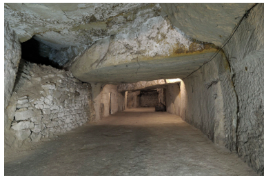
Cavité sud-est : galerie d'extraction du XIXe siècle (1). Phot. Bruno Rousseau, Phot. Youenn Communeau IVR52_20124901345NUCA
