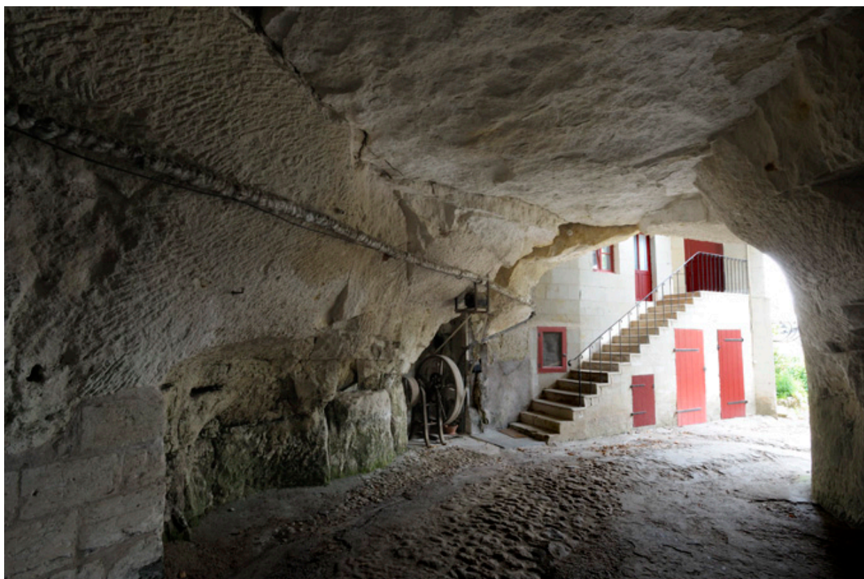
Bouche de cavage (vue à revers).
