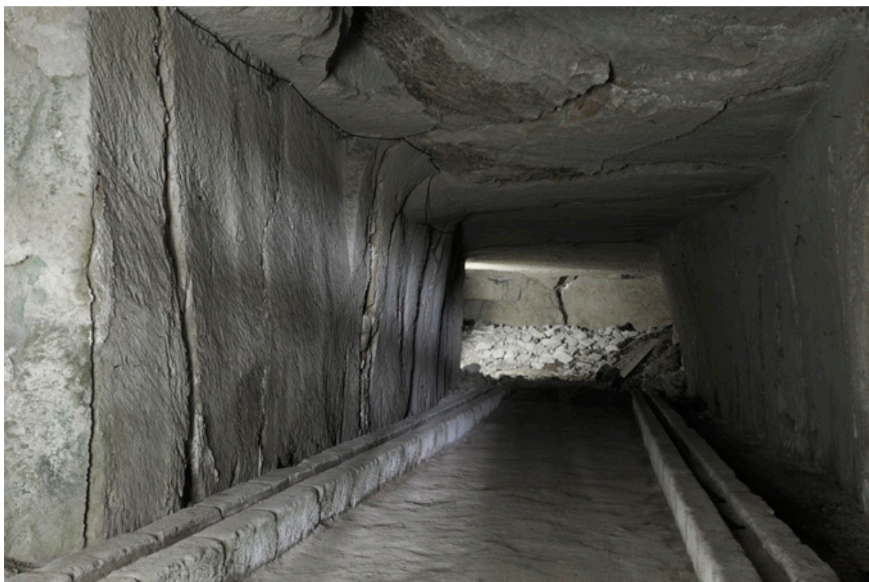
Cavité sud-ouest : galerie d'extraction du XIXe siècle devenue cave à vin avec alignements latéraux de chantiers à barriques et bouteilles.
