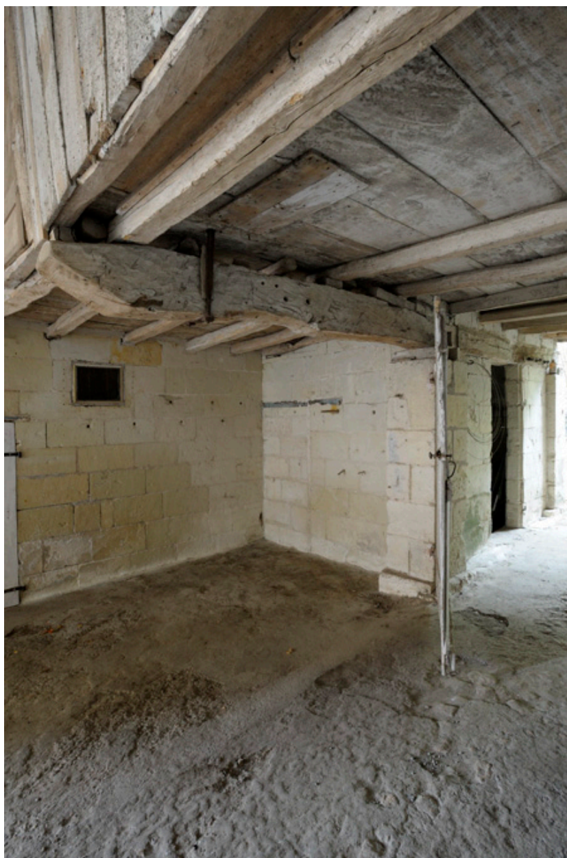
Bouche de caveau : poutre suspendue et piliers de tuffeau sous l'entrepôt en assemblage de planches.
