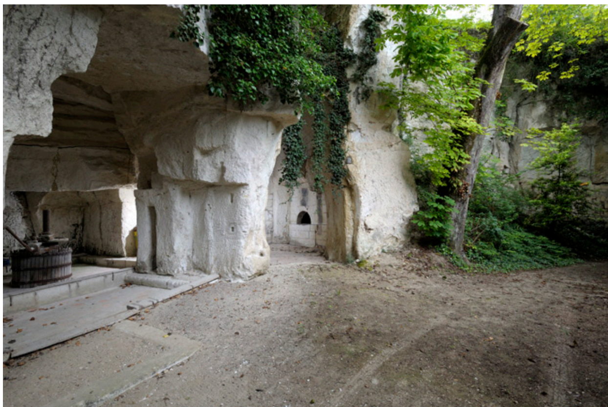
Premier fontis : cavités latérales avec pressoir et fours (2).
