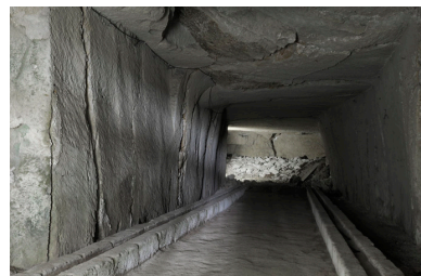
Cavité sud-ouest : galerie d'extraction du XIXe siècle devenue cave à vin avec alignements latéraux de chantiers à barriques et bouteilles. Phot. Bruno Rousseau, Phot. Youenn Communeau IVR52_20124901350NUCA
