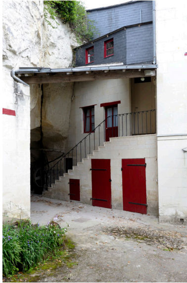
L'habitation semi-troglodytique en façade postérieure de Bellevue. Phot. Bruno Rousseau, Phot. Youenn Communeau IVR52_20124901357NUCA
