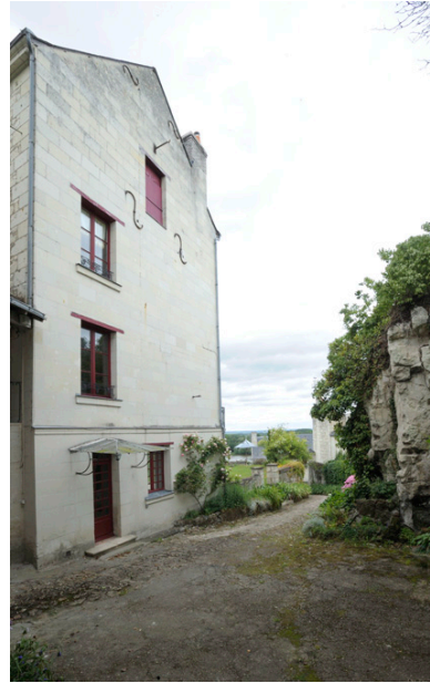
Pignon de la maison de Bellevue et voie d'accès depuis la place des Dames de Tourzel. Phot. Bruno Rousseau, Phot. Youenn Communeau IVR52_20124901358NUCA
