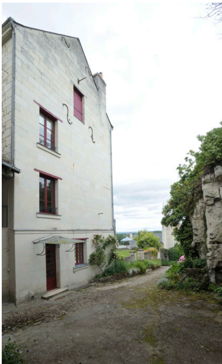
Pignon de la maison de Bellevue et voie d'accès depuis la place des Dames de Tourzel.
