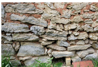
Matériaux et mises en œuvre : maçonnerie de moellons de calcaire marneux (La Petite Brosse). Phot. François Lasa IVR52_20077200680NUCA
