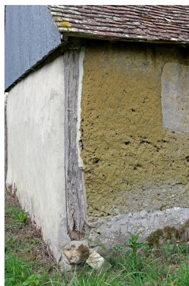
Matériaux et mises en œuvre : pan de bois enduit à la terre (Le Pesle). Phot. François Lasa IVR52_20077200702NUCA
