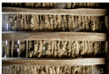
Matériaux et mises en œuvre : plafond en torchis sur éclisses (Bel Air). Phot. François Lasa IVR52_20077200768NUCA
