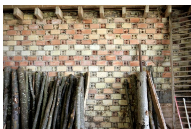
Matériaux et mises en œuvre : maçonnerie de briques creuses (La Fontaine). Phot. François Lasa IVR52_20077200740NUCA
