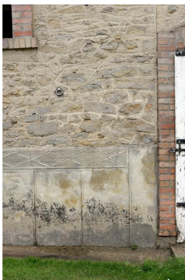
Matériaux et mises en œuvre : maçonnerie de moellons de calcaire, chambranles en briques (La Paysanterie). Phot. François Lasa IVR52_20077200638NUCA
