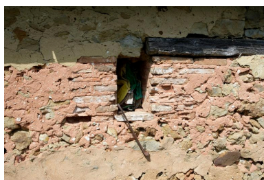
Matériaux et mises en œuvre : briques chantignolles (La Fontaine). Phot. François Lasa IVR52_20077200738NUCA
