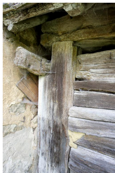
Matériaux et mises en œuvre : structure sur poteaux, remplissage de poutres de bois empilées horizontalement (Bourg, maison 1). Phot. François Lasa IVR52_20077200780NUCA
