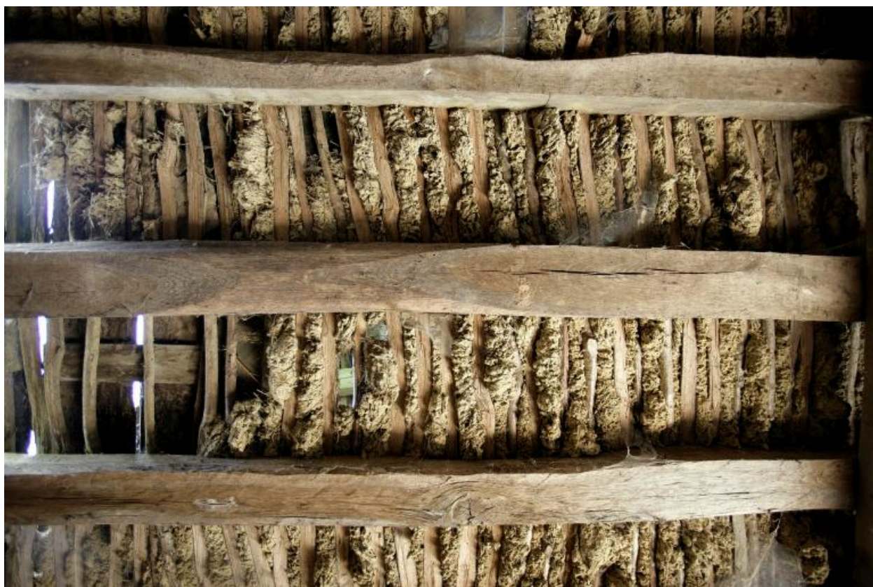
Matériaux et mises en œuvre : plafond en torchis sur éclisses (Bel Air).
