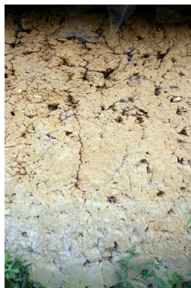
Matériaux et mises en œuvre : mur en bauge (Bel Air). Phot. François Lasa IVR52_20077200769NUCA
