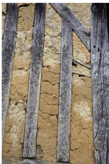
Matériaux et mises en œuvre : pan de bois hourdé en torchis sur éclisses (La Petite Brosse). Phot. François Lasa IVR52_20077200676NUCA
