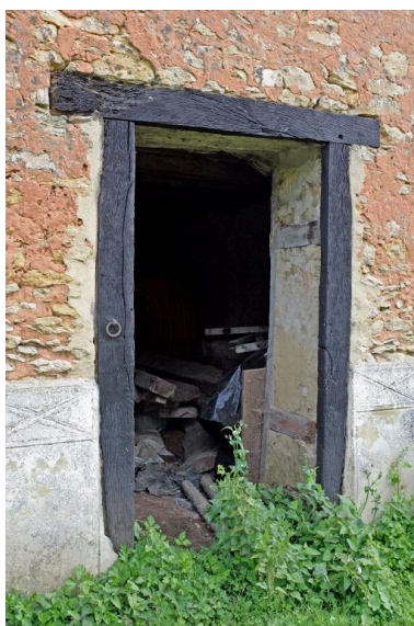
Matériaux et mises en œuvre : chambranles en bois dite carrie (La Grande Brosse). Phot. François Lasa IVR52_20077200656NUCA
