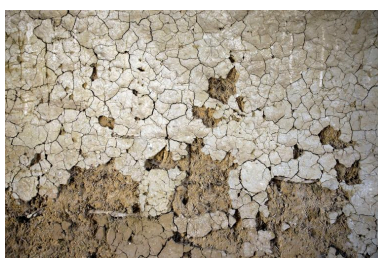
Matériaux et mises en œuvre : torchis sur lattis enduit à la terre, avec badigeon de chaux (Bel Air). Phot. François Lasa IVR52_20077200767NUCA
