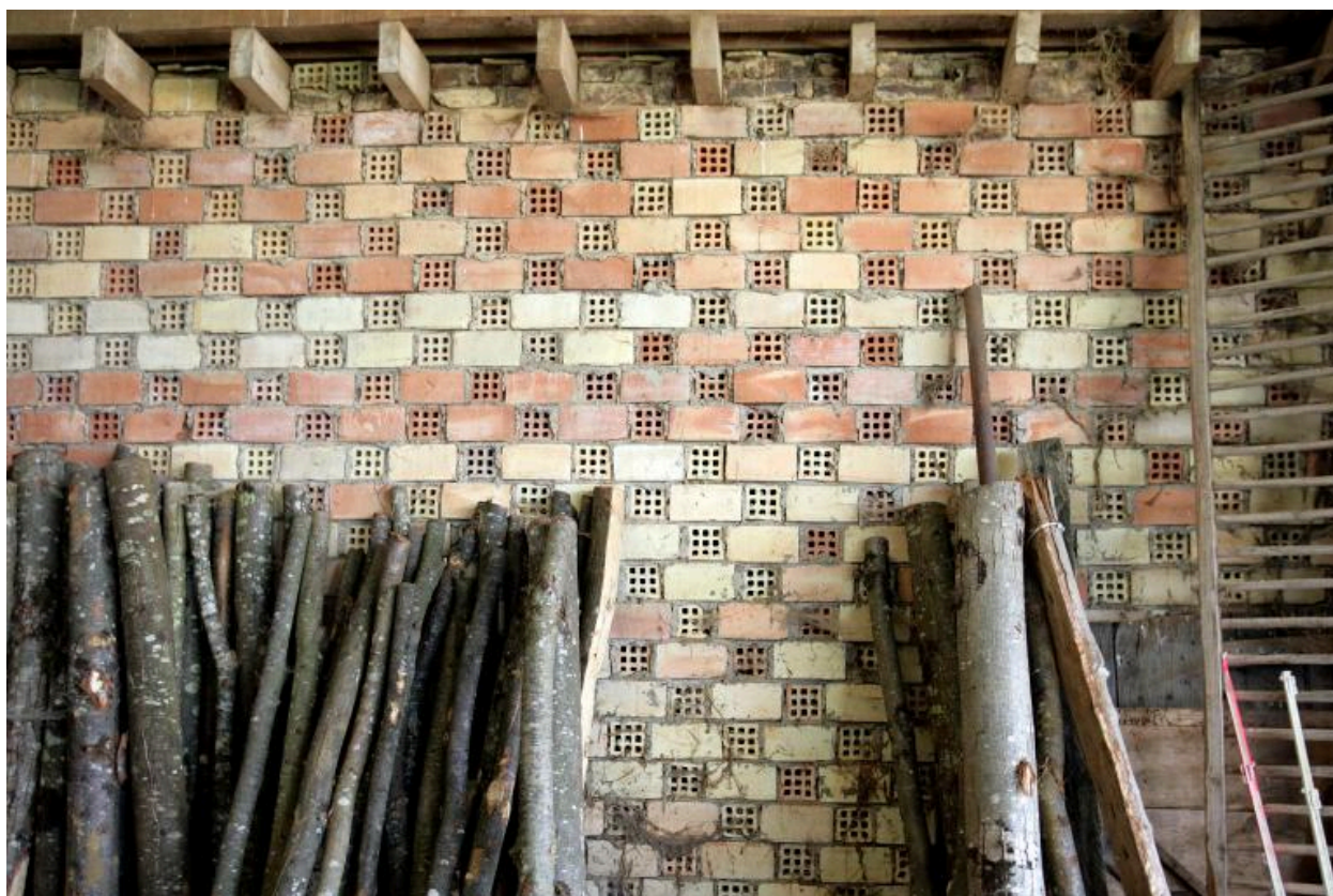
Matériaux et mises en œuvre : maçonnerie de briques creuses (La Fontaine).
