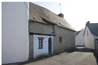
Vue du n° 13 rue Courte-Baille. Phot. Denis Pillet IVR52_20084400364NUCA
