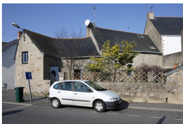
Façade arrière du n° 13 rue Courte-Baille. Phot. Denis Pillet IVR52_20084400271NUCA
