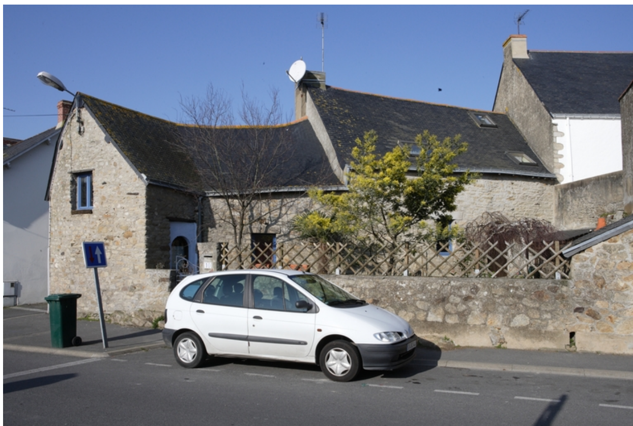
Façade arrière du n° 13 rue Courte-Baille.
