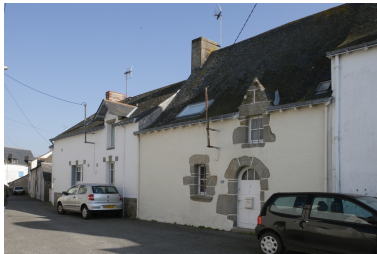
Vue des n° 5 et 7 rue Courte-Baille. Phot. Denis Pillet IVR52_20084400367NUCA
