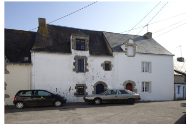
Vue des n° 9 et 11 rue Courte-Baille. Phot. Denis Pillet IVR52_20084400365NUCA
