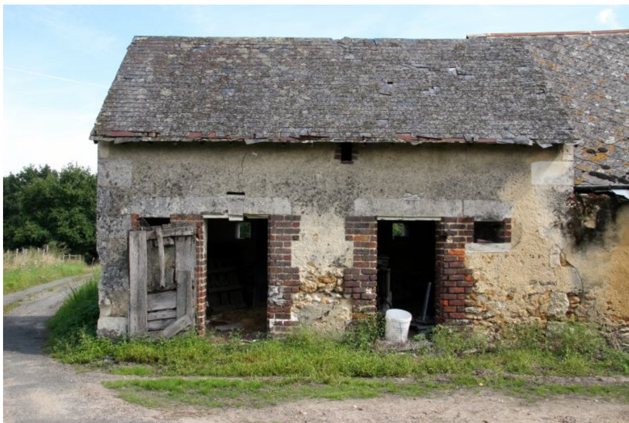
Les toits à porcs fin XIXe siècle : remarquer l'usage de la grosse brique foncée pour les jambages.
