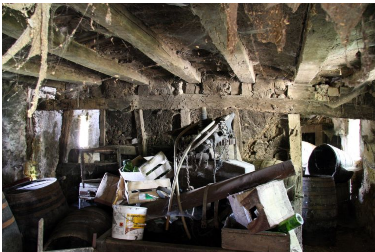
La maison d'habitation, la chambre froide : mur en pan-de-bois pour séparer des dépendances (pignon entier ?).
