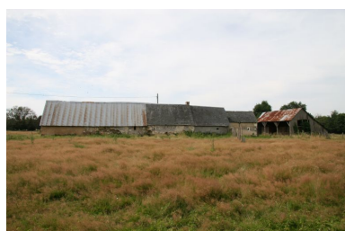
Façade postérieure de la vieille ferme. Phot. Jean-Baptiste Darrasse IVR52_20077201113NUCA
