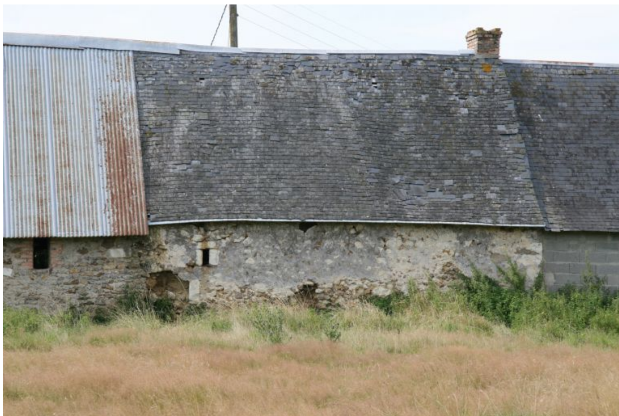
La maison d'habitation : façade postérieure sans fenêtre ni porte.
