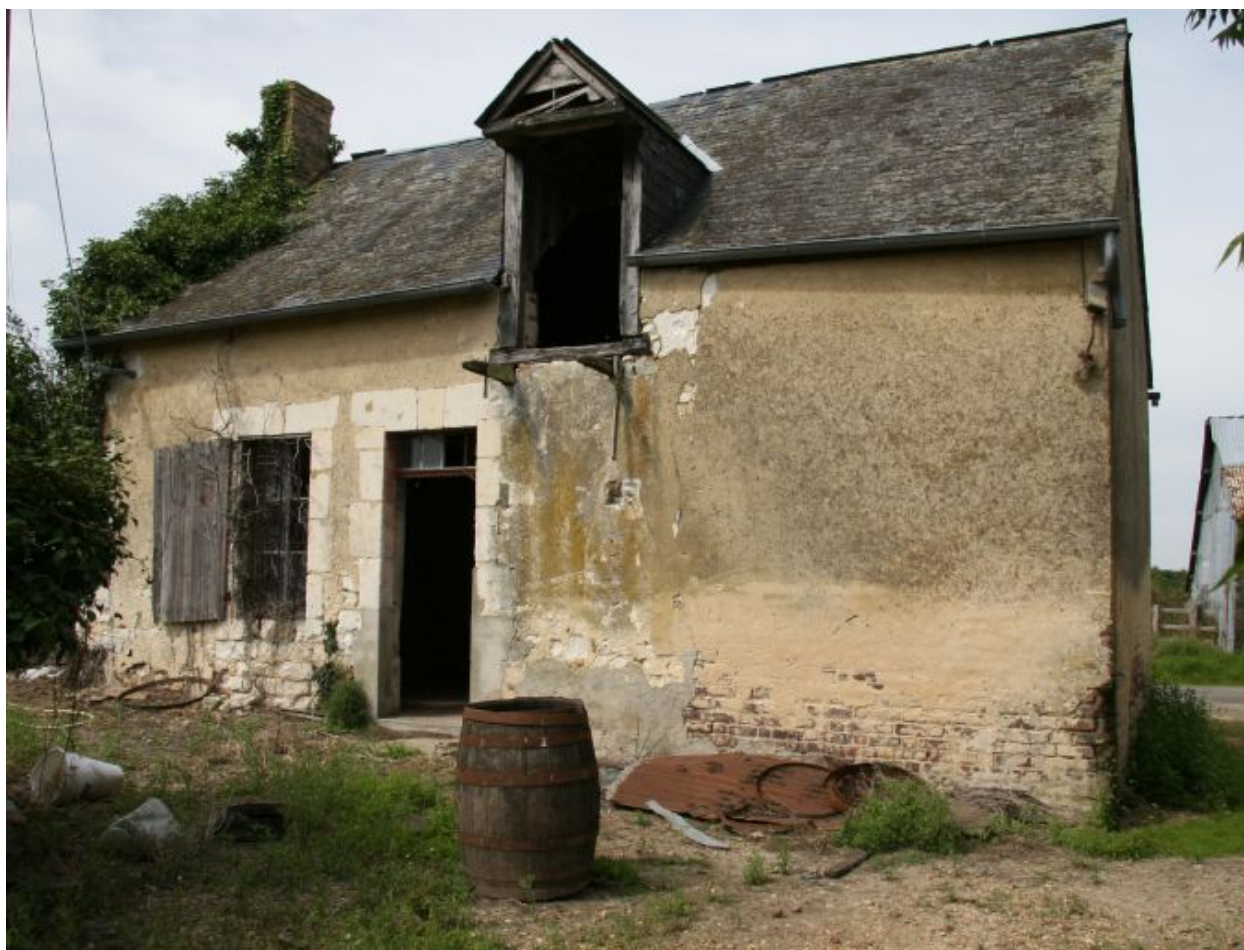
La nouvelle maison : façade sur cour.
