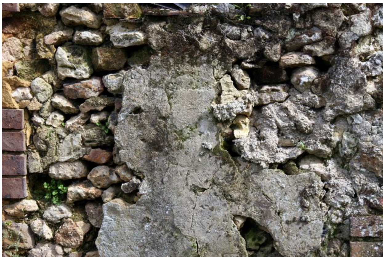
Maçonnerie du mur de façade : rognons de silex.
