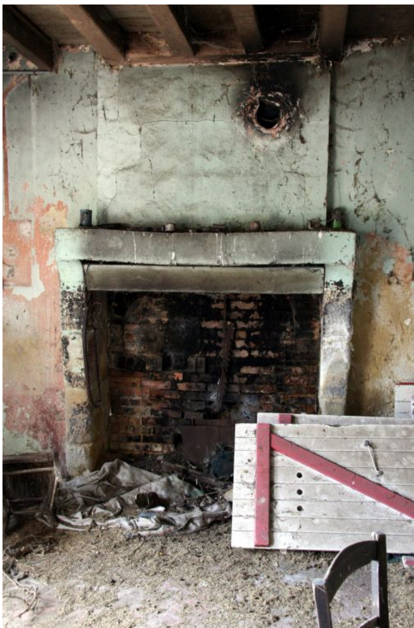
La nouvelle maison : la cheminée.
