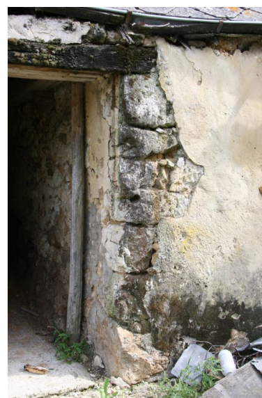
la maison d'habitation : jambage de la porte du cellier adossé au pignon de la cheminée. Phot. Jean-Baptiste Darrasse IVR52_20077201103NUCA
