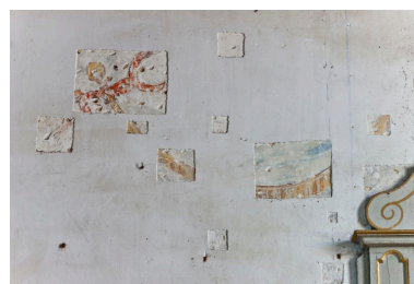
Chapelle de la Vierge, mur est, détail : peinture (18e s. ?) sous l'enduit. Phot. Yves Guillotin IVR52_20127200899NUCA
