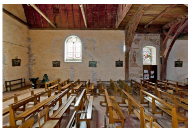
Nef : mur nord, avec entrée actuelle et construction en charpente du clocher. Phot. Yves Guillotin IVR52_20127200882NUCA
