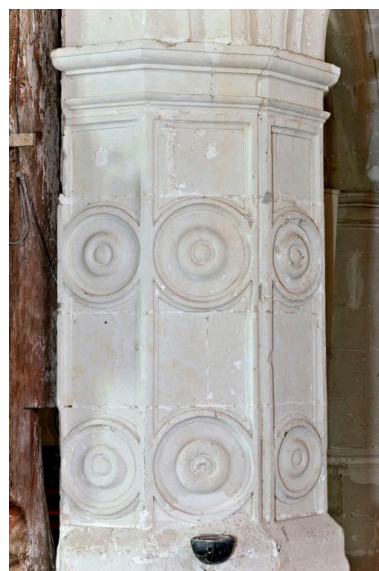
Bas-côté sud : détail des moulurations de la pile. Phot. Yves Guillotin IVR52_20127200896NUCA
