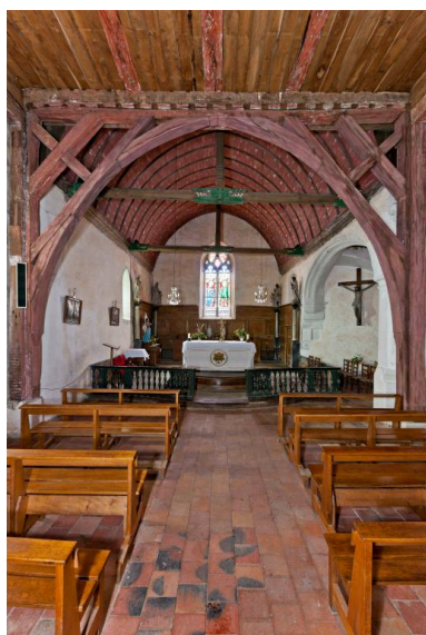
Vue intérieure prise depuis la nef. Phot. Yves Guillotin IVR52_20127200876NUCA
