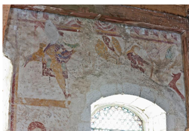
Nef, mur nord, détail d'une peinture romane, registre supérieur : la Chasse de saint Gilles. Phot. Yves Guillotin IVR52_20127200902NUCA
