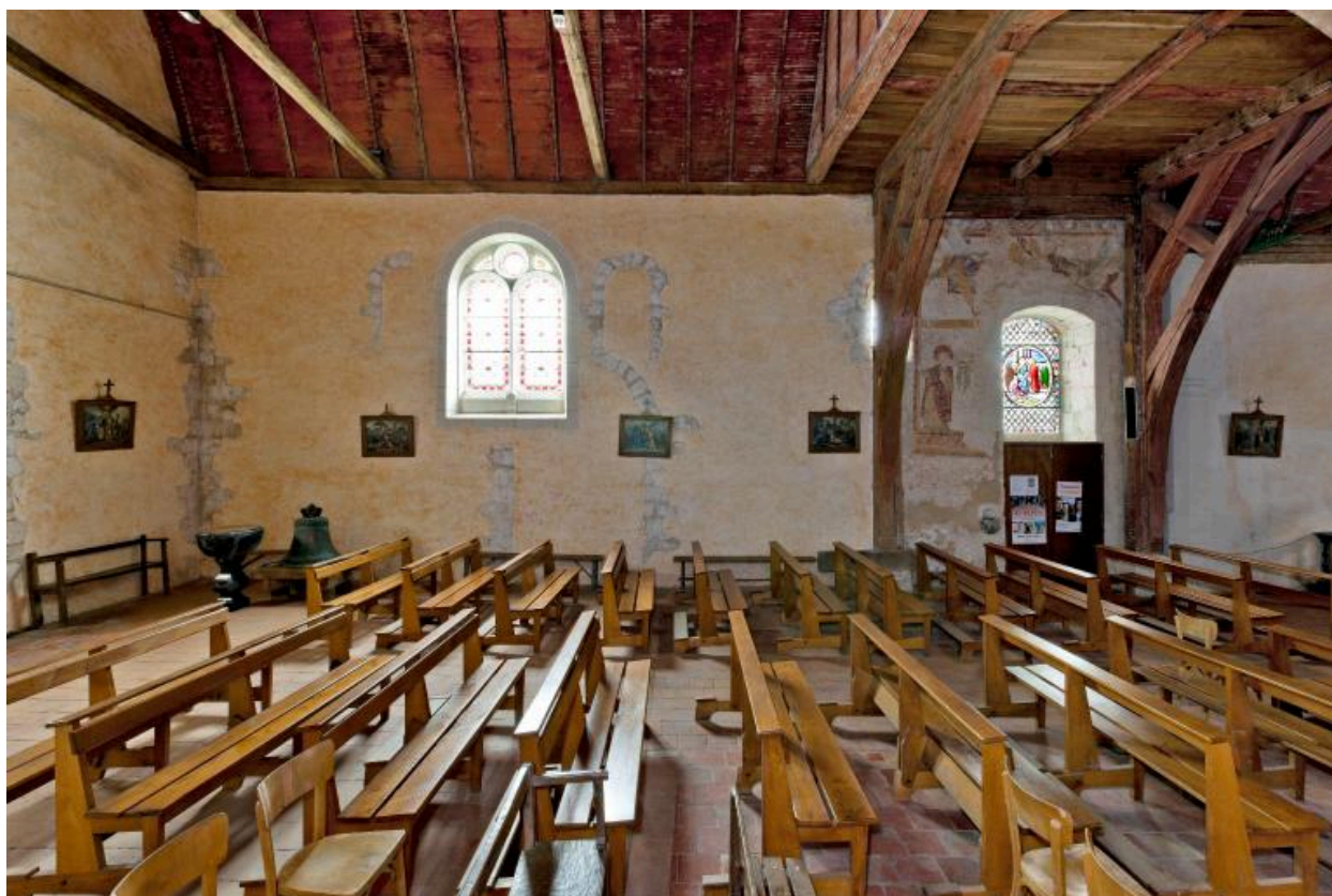
Nef : mur nord, avec entrée actuelle et construction en charpente du clocher.
