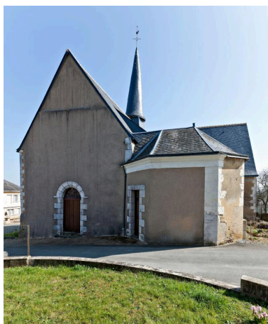
Façade ouest (entrée principale) de l'église, et premier bâtiment de mairie. Phot. Yves Guillotin IVR52_20127200395NUCA
