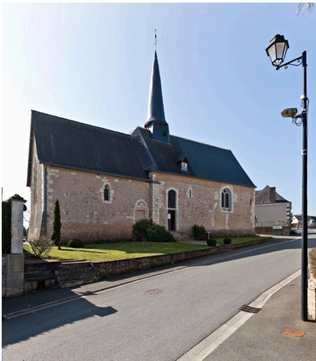
Vue d'ensemble prise depuis le nord-est.
