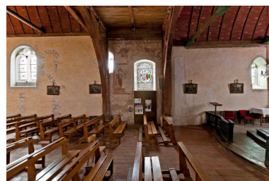
Détail du mur nord de l'église. Phot. Yves Guillotin IVR52_20127200883NUCA
