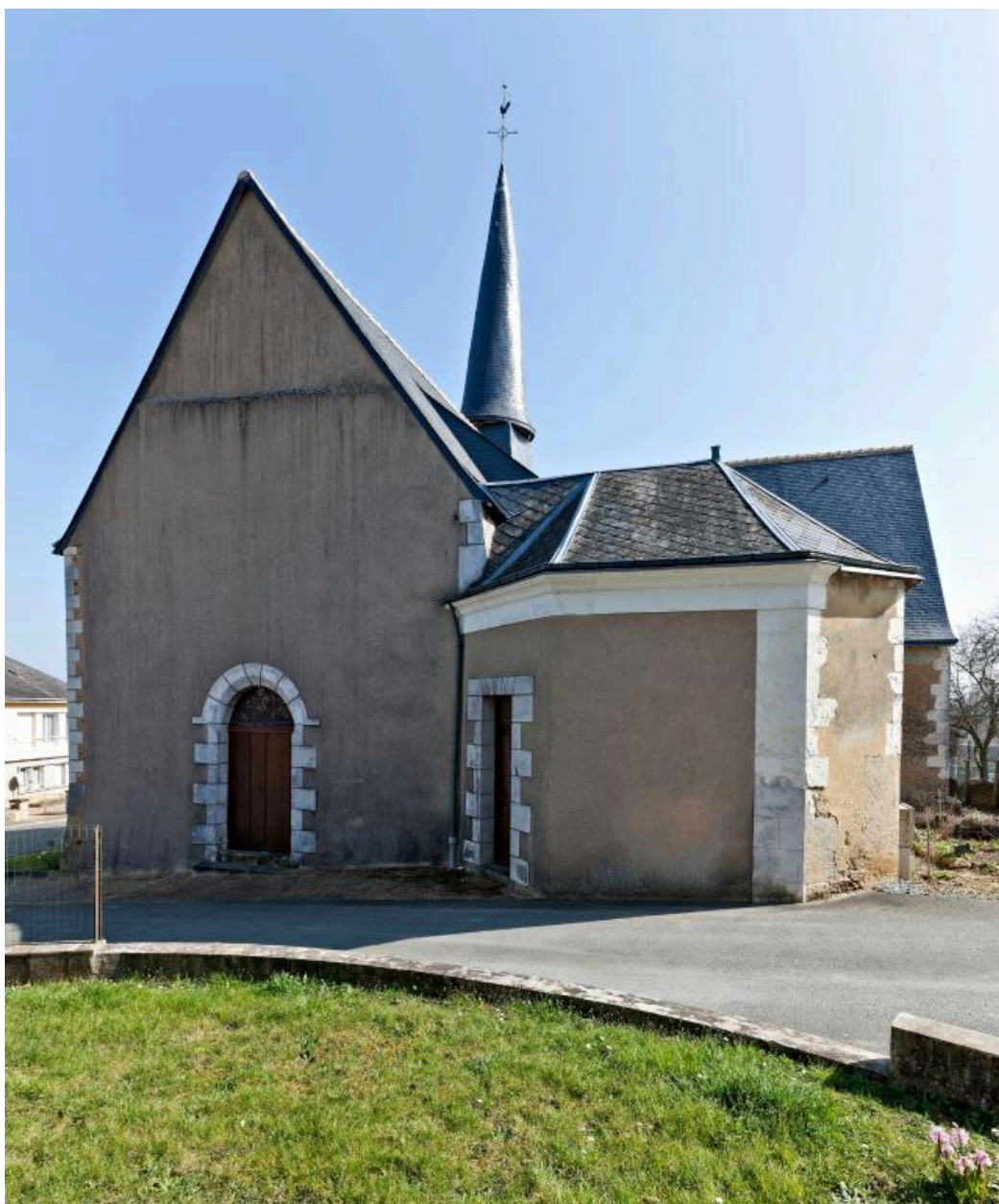
Façade ouest (entrée principale) de l'église, et premier bâtiment de mairie.
