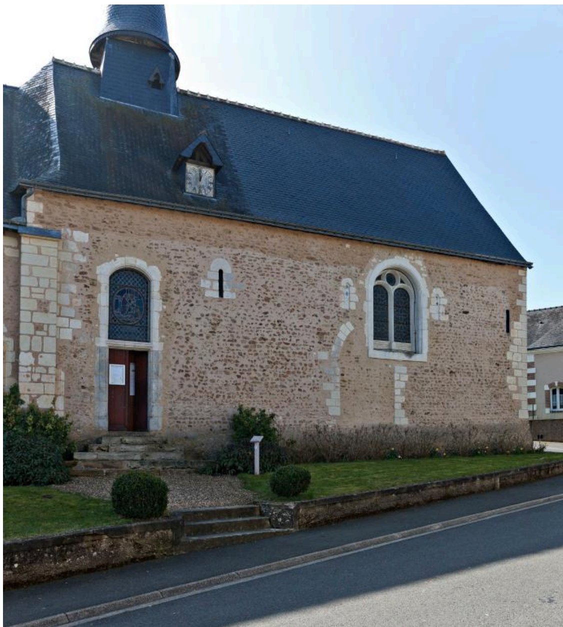
Nef, façade nord.
