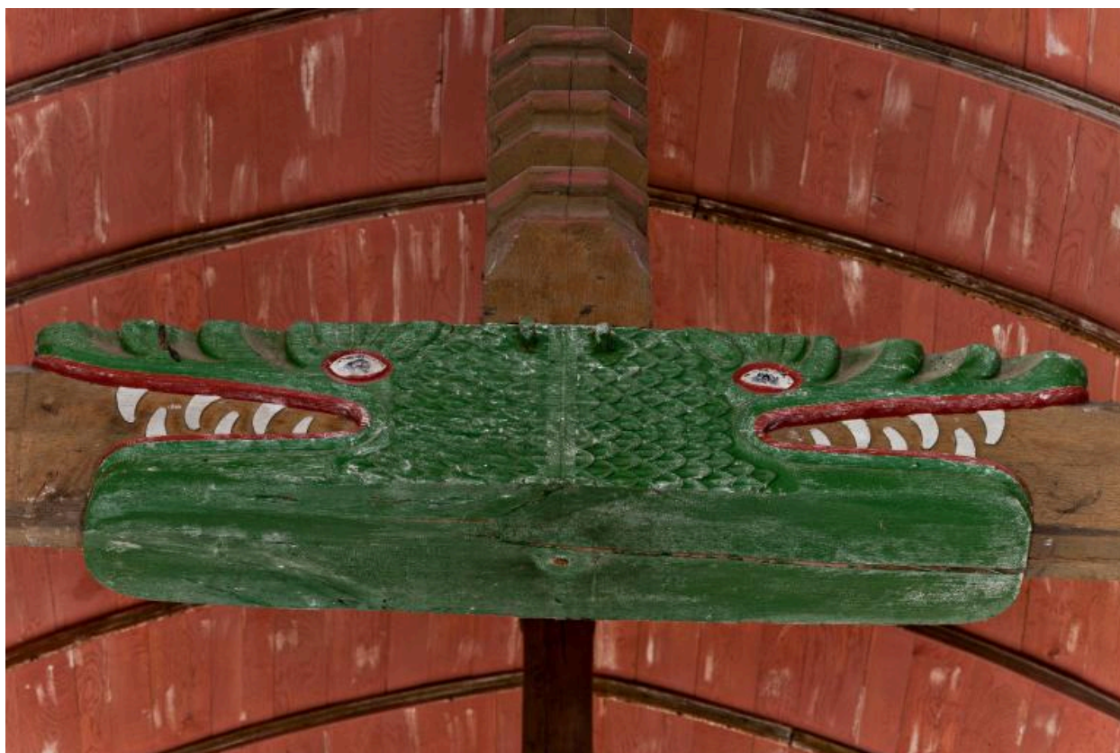
Chœur : détail des engoulants au centre d'un tirant de la charpente.
