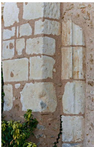
Nef, façade nord : contrefort et vestiges d'une moulure. Phot. Yves Guillotin IVR52_20127200406NUCA
