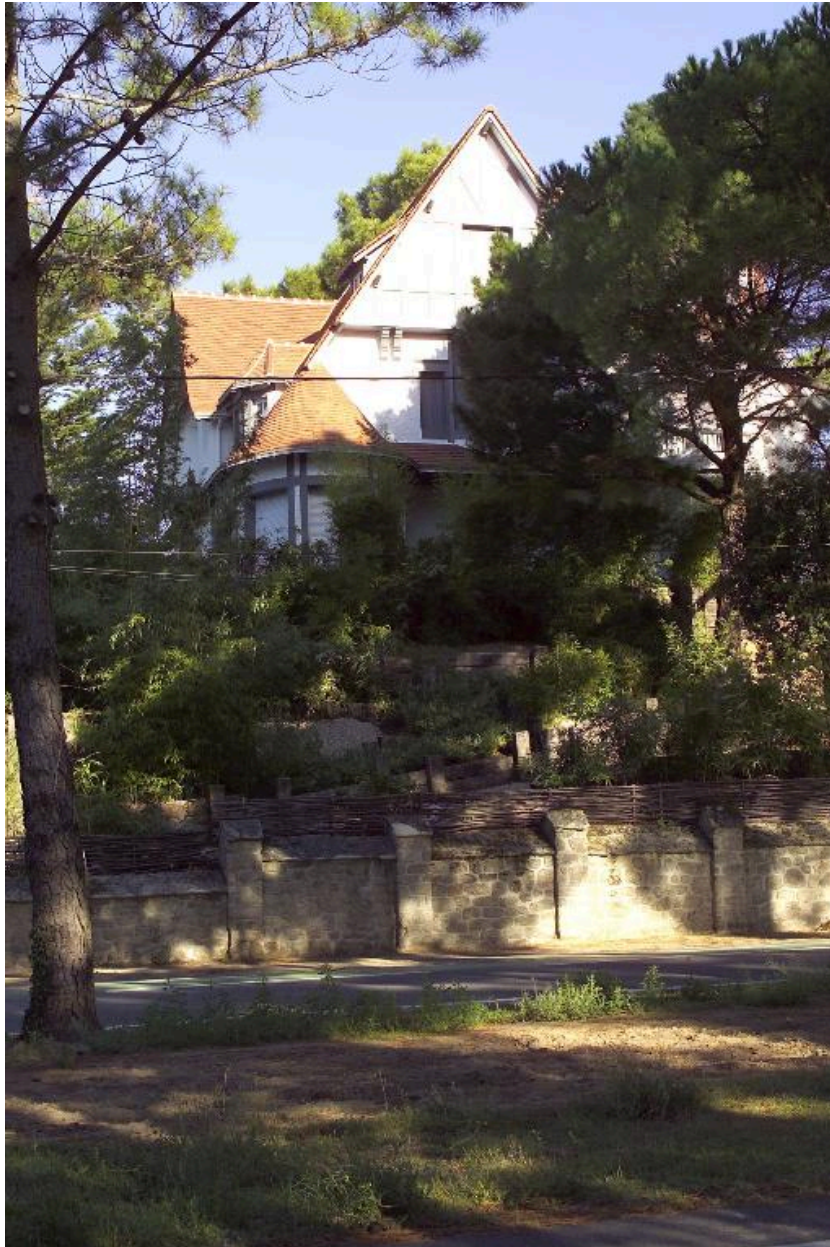
Vue d'ensemble de la villa Ar Goed.
