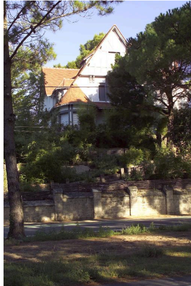
Vue d'ensemble de la villa Ar Goed.
