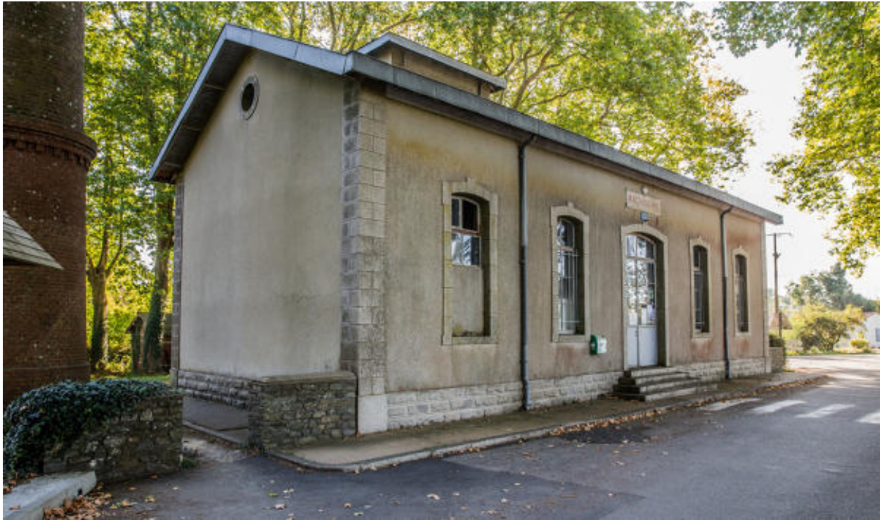
Façade antérieure et pignon nord.
