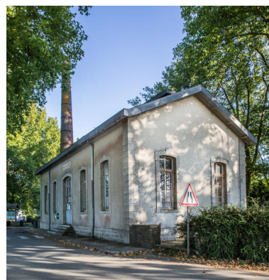
Façade antérieure et pignon sud. Phot. Pierre-Bernard Fourny IVR52_20184400518NUCA
