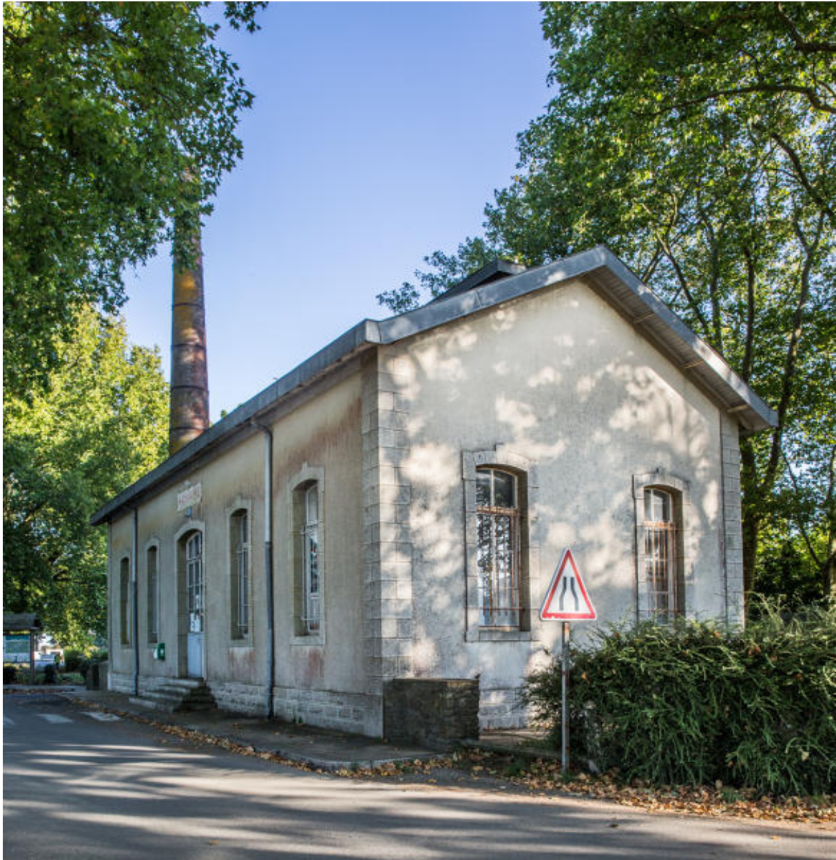
Façade antérieure et pignon sud.
