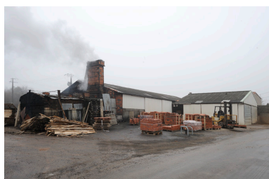
Vue générale de la briqueterie-tuilerie Corbet. Phot. Bruno Rousseau IVR52_20114900337NUCA
