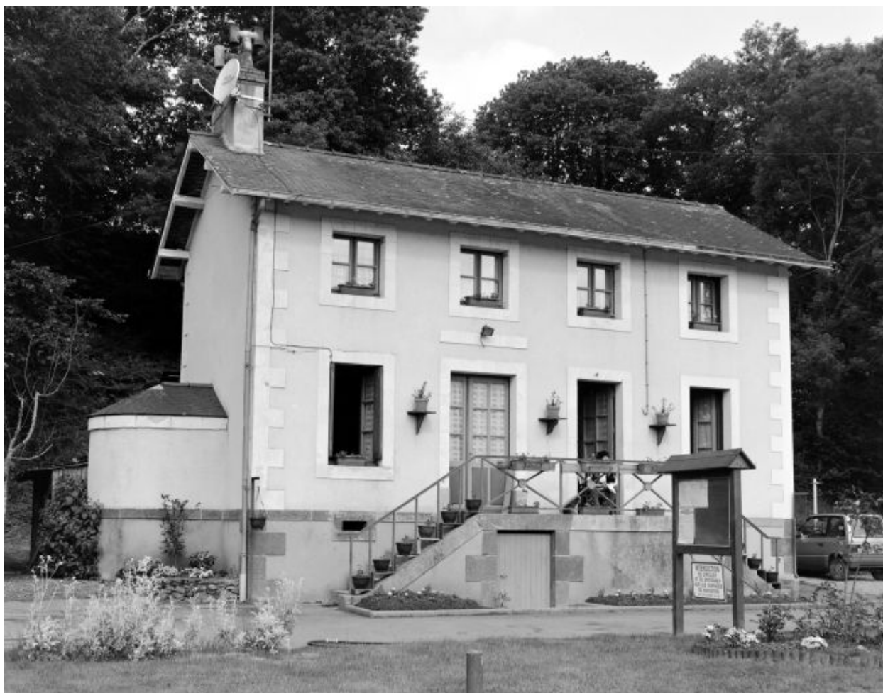
La maison éclusière.
