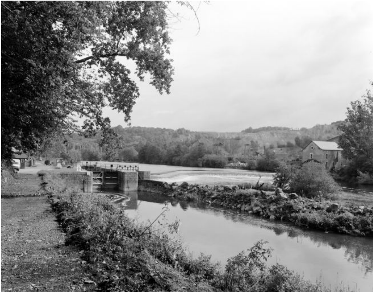
Vue d'ensemble du site depuis la rive droite en aval : écluse, barrage, ancien moulin.
