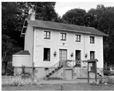
La maison éclusière. Phot. François Lasa IVR52_20025300701X
