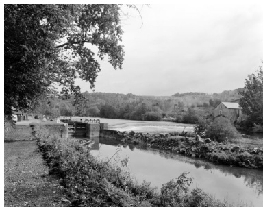
Vue d'ensemble du site depuis la rive droite en aval : écluse, barrage, ancien moulin. Phot. François Lasa IVR52_20025300699X
