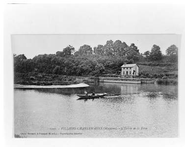
Vue du site depuis la rive gauche : barrage, pertuis, écluse, maison éclésièrè. Autr. Drouard, Repro. François Lasa IVR52_20015300690X
