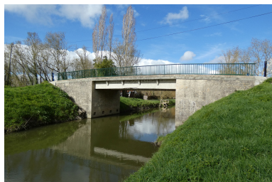
Le pont de la Garenne de Sainte-Christine vu depuis le sud. Phot. Yannis Suire IVR52_20238500974NUCA
