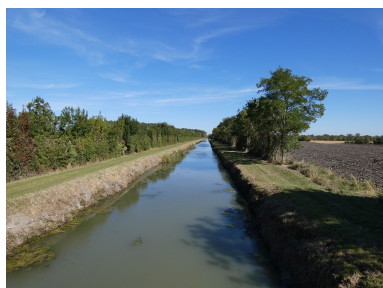
Le canal de la Vieille Autise vu depuis le pont Noir, à Damvix, en direction de l'amont, vers le nord-est. Phot. Yannis Suire IVR52_20228500738NUCA
