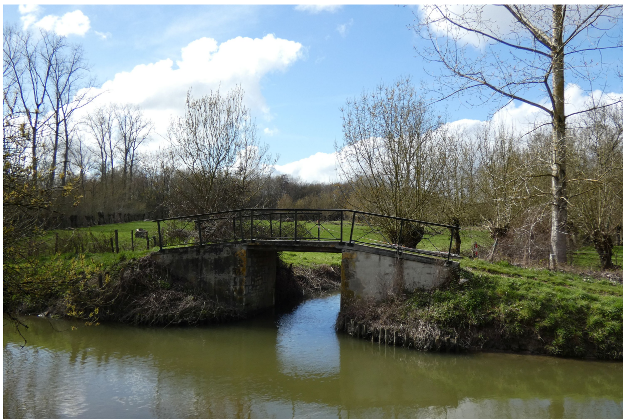
Passerelle de halage sur la rive droite du canal, à la Garenne de Sainte-Christine.
