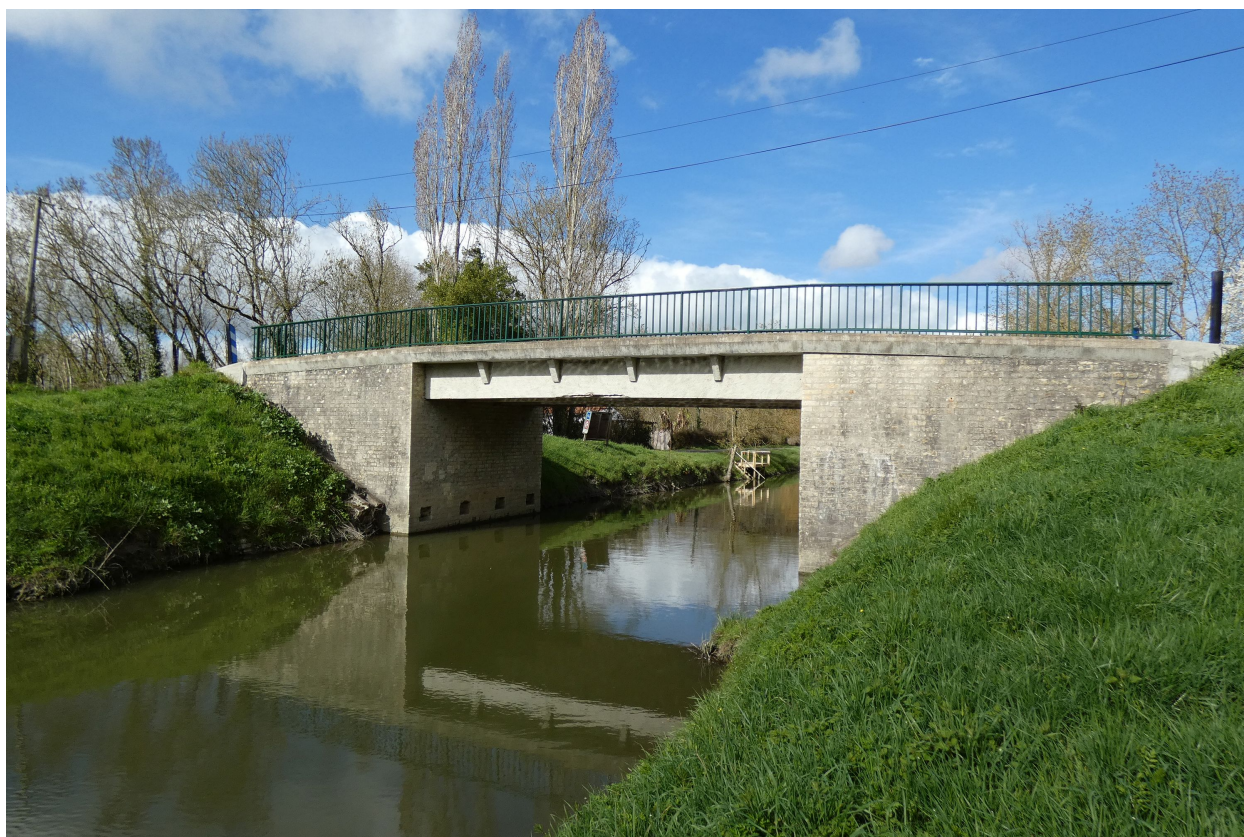
Le pont de la Garenne de Sainte-Christine vu depuis le sud.
