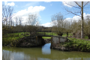
Passerelle de halage sur la rive droite du canal, à la Garenne de Sainte-Christine. Phot. Yannis Suire IVR52_20238500971NUCA
