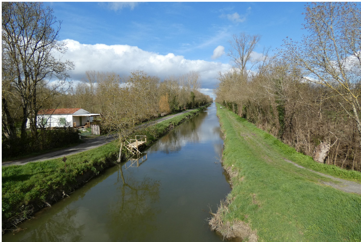
Le canal de la Vieille Autise vu depuis le pont de la Garenne de Sainte-Christine, en direction du nord-est.
