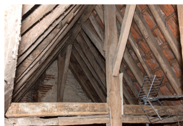
Vue du poinçon central de la charpente. Phot. Bruno Rousseau IVR52_20207201196NUCA
