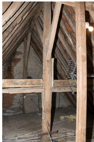
Vue générale de la charpente. Phot. Bruno Rousseau IVR52_20207201195NUCA
