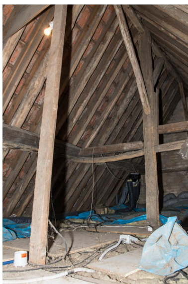
Vue générale de la charpente. Phot. Bruno Rousseau IVR52_20207201193NUCA
