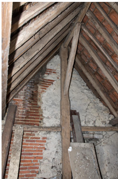
Vue du poinçon latéral nord. Phot. Bruno Rousseau IVR52_20207201192NUCA
