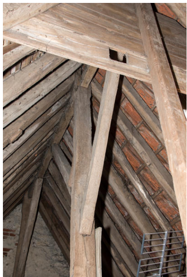
Vue de la ferme de charpente. Phot. Bruno Rousseau IVR52_20207201194NUCA
