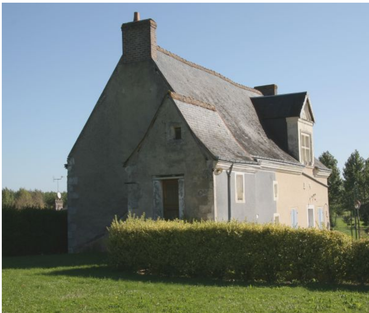
Vue de volume prise de la terrasse.
