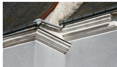
Façade antérieure sur cour, détail : ressaut de la corniche sur la tourelle. Phot. Jean-Baptiste Darrasse IVR52_20077201867NUCA
