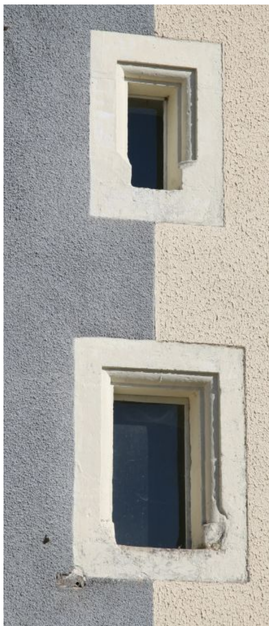
Façade antérieure sur cour, détail : baies de l'escalier.
