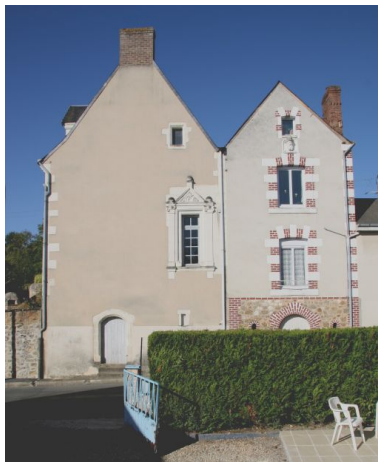
Pignon sur la rue avec la maison accollée début XXe siècle. Phot. Jean-Baptiste Darrasse IVR52_20077201858NUCA
