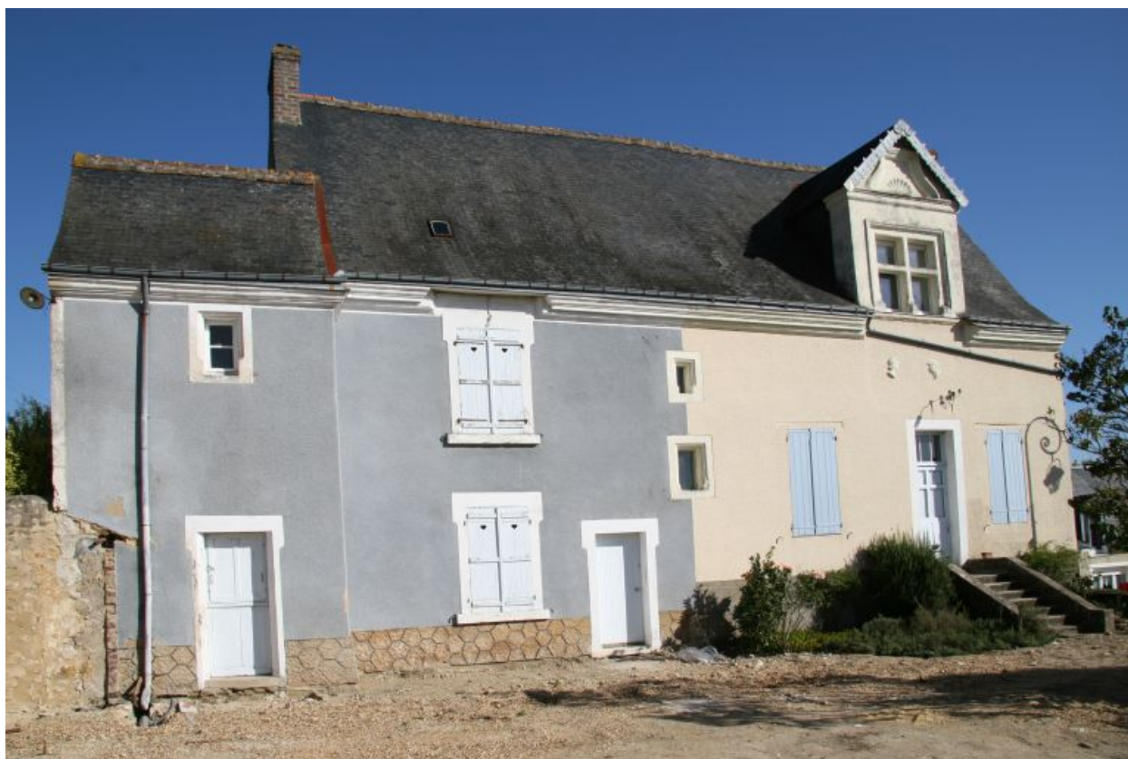
Façade antérieure sur cour.
