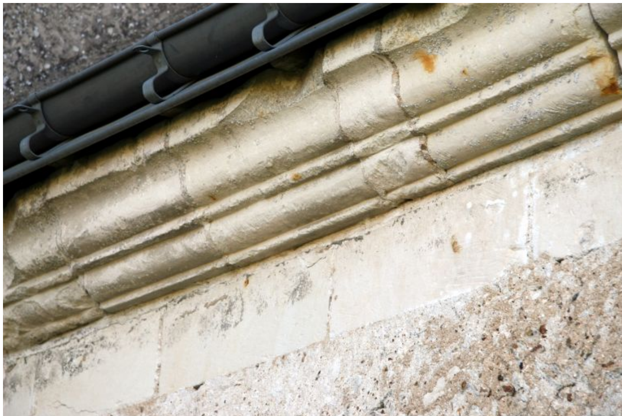
Façade postérieure : corniche.
