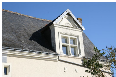
Façade antérieure sur cour : lucarne. Phot. Jean-Baptiste Darrasse IVR52_20077201866NUCA
