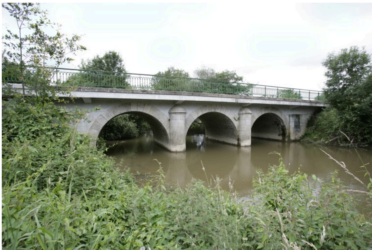
Vue d'amont, depuis la rive gauche.
