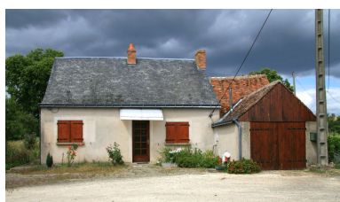
Ferme de la Roussière, la vieille maison. Phot. Jean-Baptiste Darrasse IVR52_20087201978NUCA
