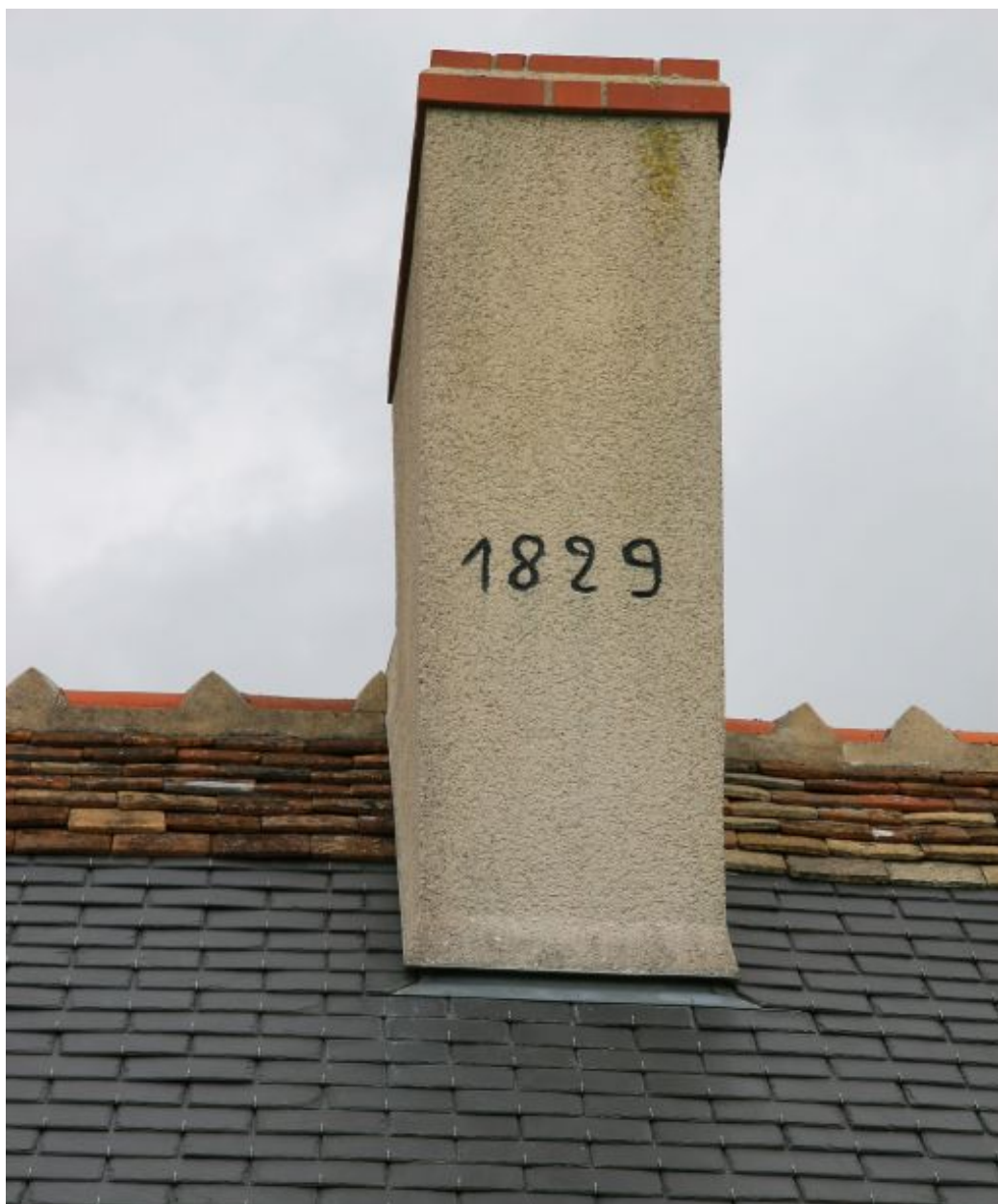
Ferme de la Roussière, la nouvelle maison : date portée 1829.
