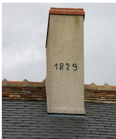
Ferme de la Roussière, la nouvelle maison : date portée 1829. Phot. Jean-Baptiste Darrasse IVR52_20087201981NUCA
