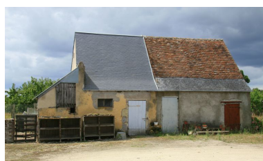
Ferme de la Roussière, les étables. Phot. Jean-Baptiste Darrasse IVR52_20087201977NUCA
