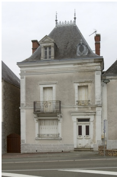
Le corps nord vu depuis la route. Phot. François Lasa IVR52_20045303333NUCA
