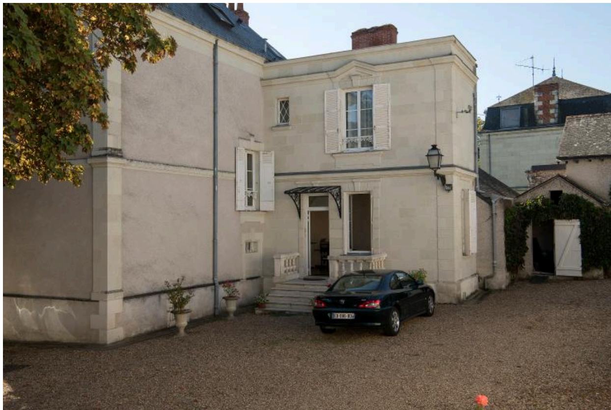
Vue de la façade sur la cour.
