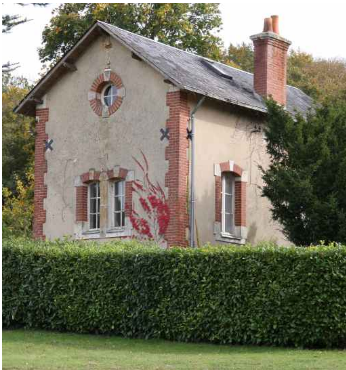
Les dépendances, vue de volume : pignon nord-ouest.
