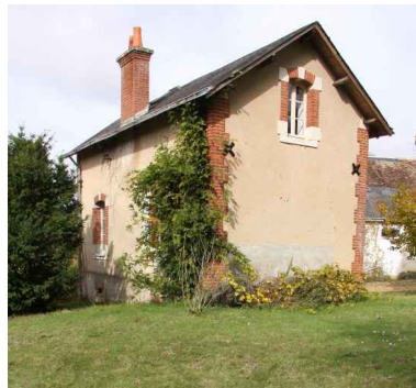
Les dépendances, vue de volume : pignon sud-est. Phot. Jean-Baptiste Darrasse IVR52_20087202242NUCA
