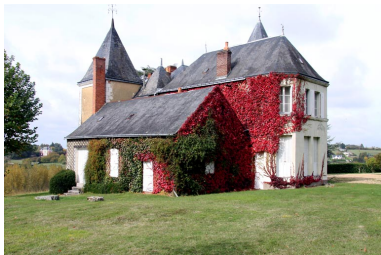
Le manoir : vue de volume prise du sud-est. Phot. Jean-Baptiste Darrasse IVR52_20087202243NUCA
