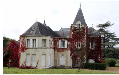
Le manoir : façade postérieure. Phot. Jean-Baptiste Darrasse IVR52_20087202241NUCA
