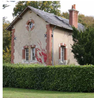
Les dépendances, vue de volume : pignon nord-ouest. Phot. Jean-Baptiste Darrasse IVR52_20087202246NUCA
