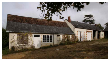
La ferme. Phot. Jean-Baptiste Darrasse IVR52_20087202239NUCA
