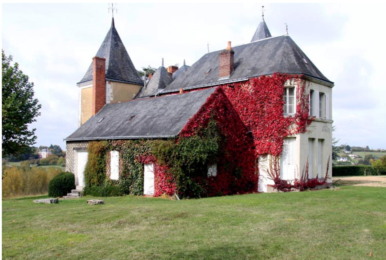
Le manoir : vue de volume prise du sud-est.
