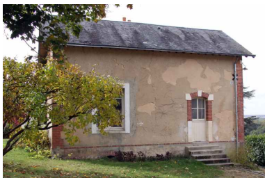
Les dépendances : façade antérieure. Phot. Jean-Baptiste Darrasse IVR52_20087202240NUCA
