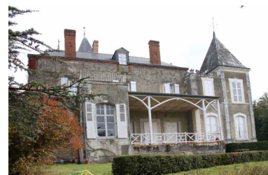
Le manoir : façade antérieure. Phot. Jean-Baptiste Darrasse IVR52_20087202244NUCA
