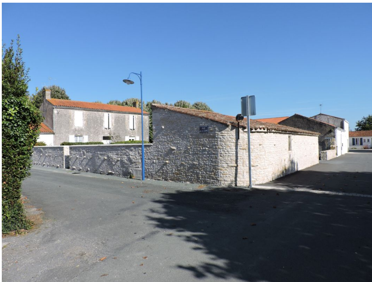
L'ancien presbytère et sa remise vus depuis le sud-ouest.
