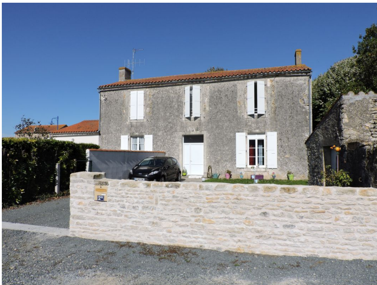
Le logis vu depuis le sud.
