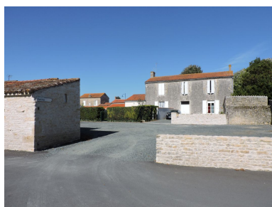
L'ancien presbytère vu depuis le sud. Phot. Yannis Suire IVR52_20188500542NUCA
