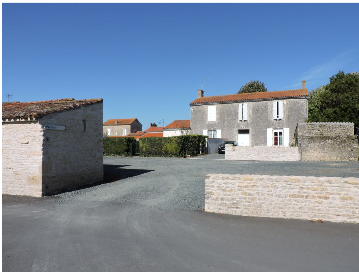
L'ancien presbytère vu depuis le sud.
