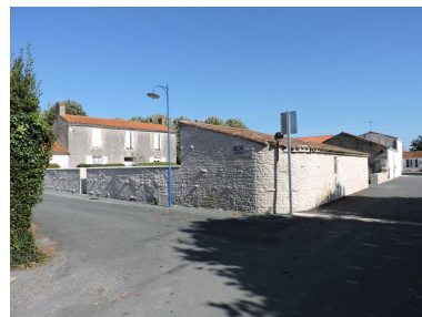
L'ancien presbytère et sa remise vus depuis le sud-ouest. Phot. Yannis Suire IVR52_20188500557NUCA
