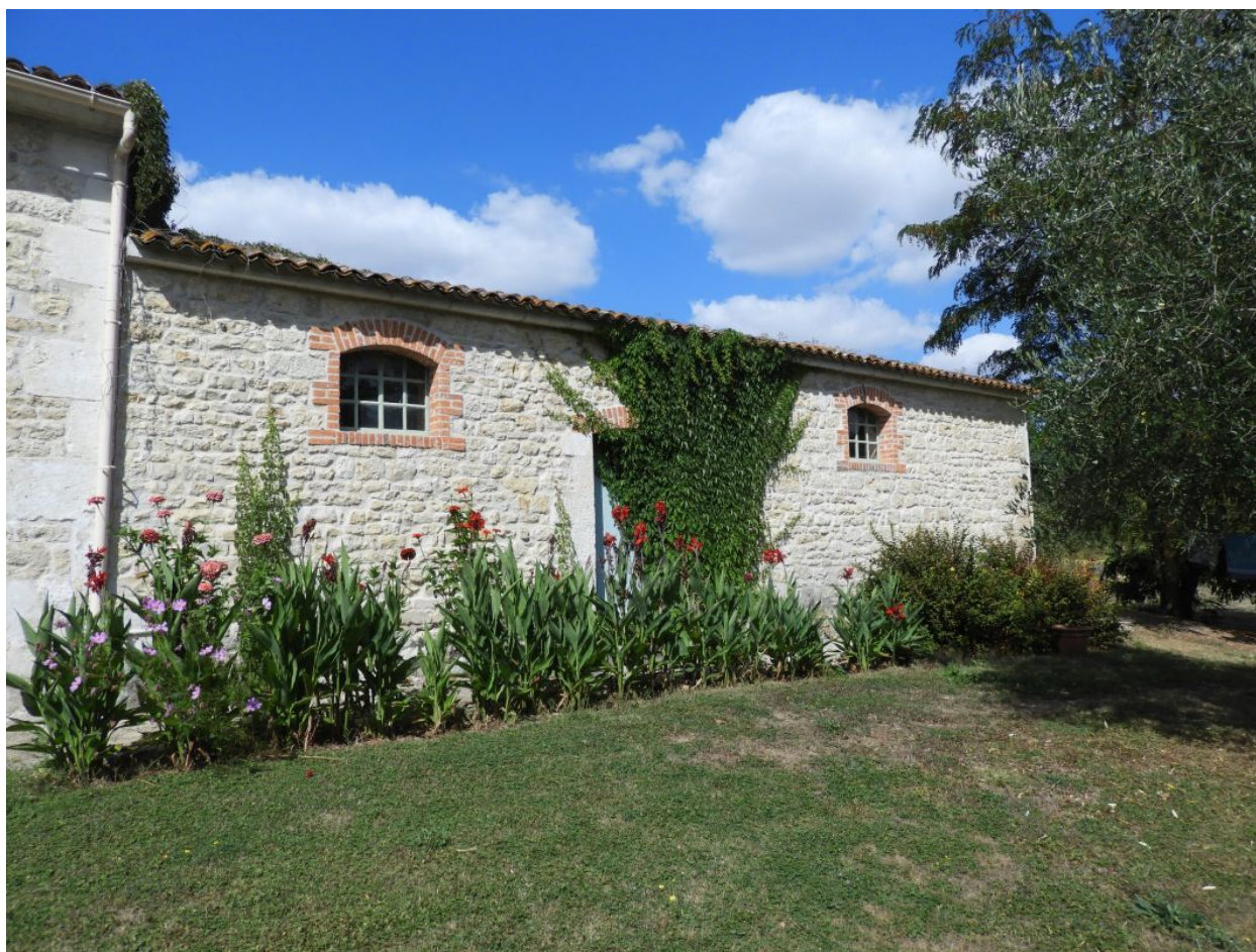
L'ancienne grange-étable-écurie dans le prolongement du logis à droite.
