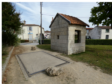
L'abri et le pont bascule vus depuis le sud-ouest. Phot. Yannis Suire IVR52_20228500447NUCA
