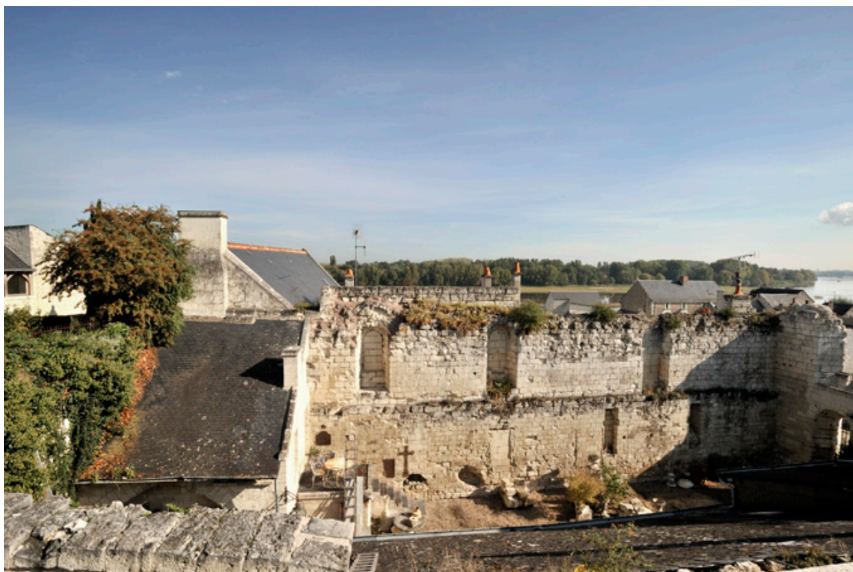
Vue d'ensemble : vestiges du bâtiment avec, en arrière-plan à gauche, le Logis dit de la Dame de Montsoreau.
