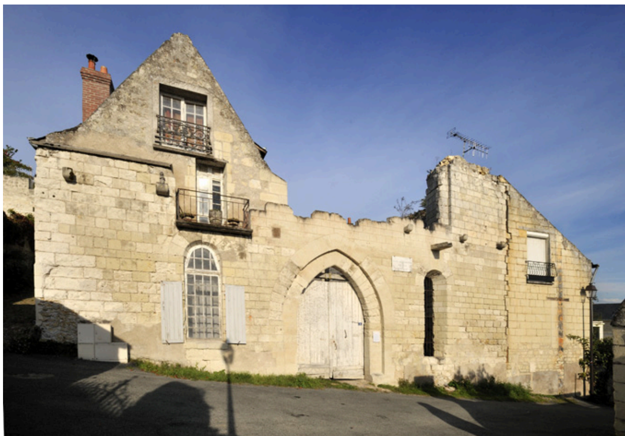
Vue générale : façade principale.
