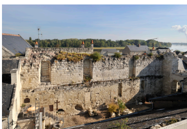
Mur nord, parement intérieur.
