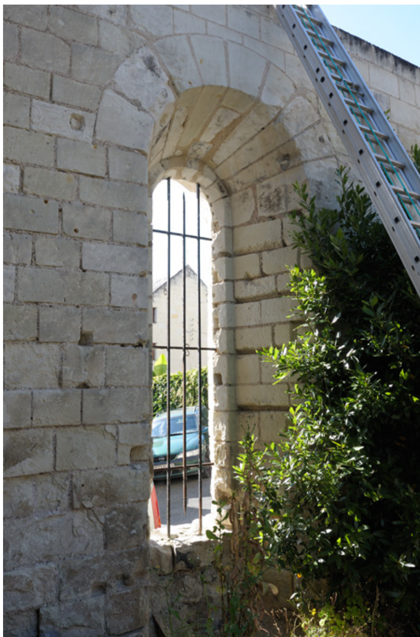
Mur est, niveau bas, première baie en partant du nord : large et haute fenêtre plein-cintre.
