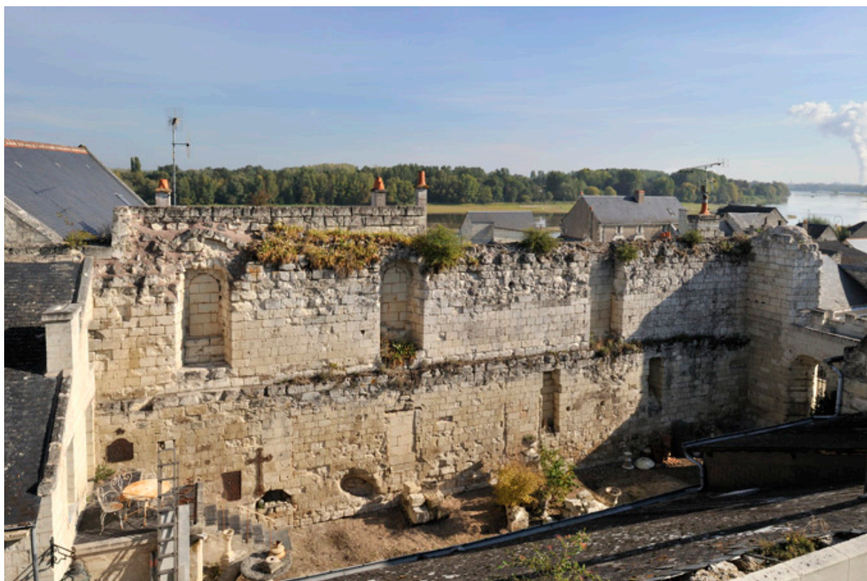
Mur nord, parement intérieur.
