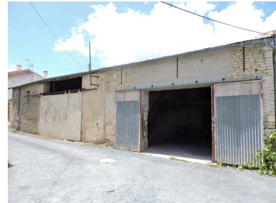
Les dépendances, dont une ancienne habitation, à droite, vues depuis l'est.
