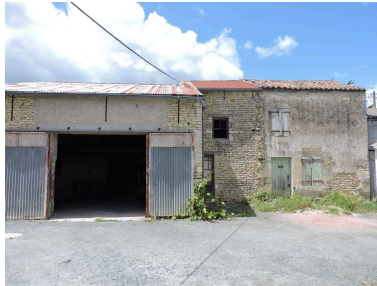
La maison, à droite, et une des dépendances, ancienne habitation, à gauche, vues depuis l'est.
