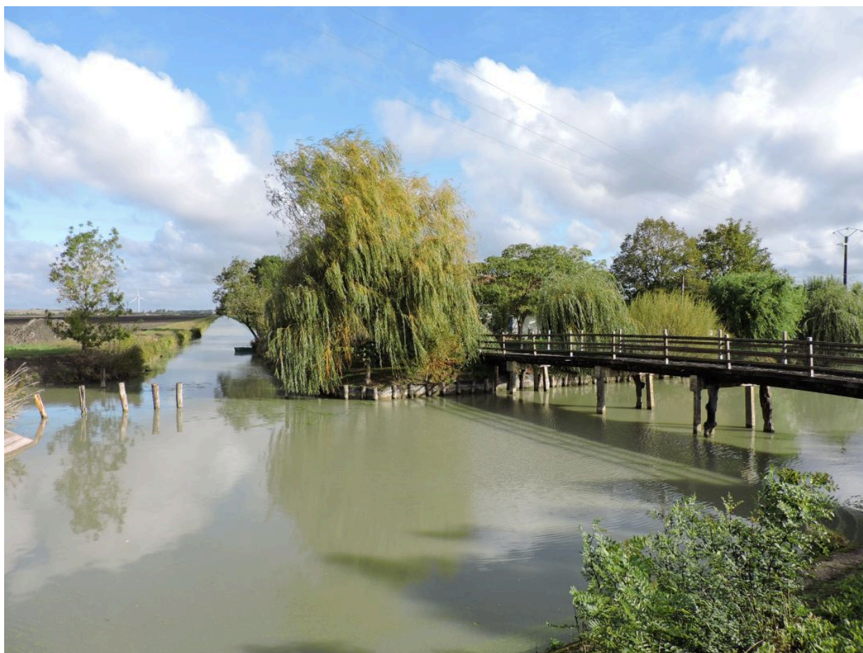
La Grande Cabane et sa passerelle par-dessus le canal de Vix, vues depuis le sud-ouest.
