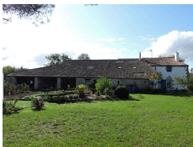
Les dépendances et le logis, à droite, vus depuis le nord. Phot. Yannis Suire IVR52_20198503136NUCA
