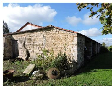
Les dépendances vues depuis le nord-est. Phot. Yannis Suire IVR52_20198503133NUCA
