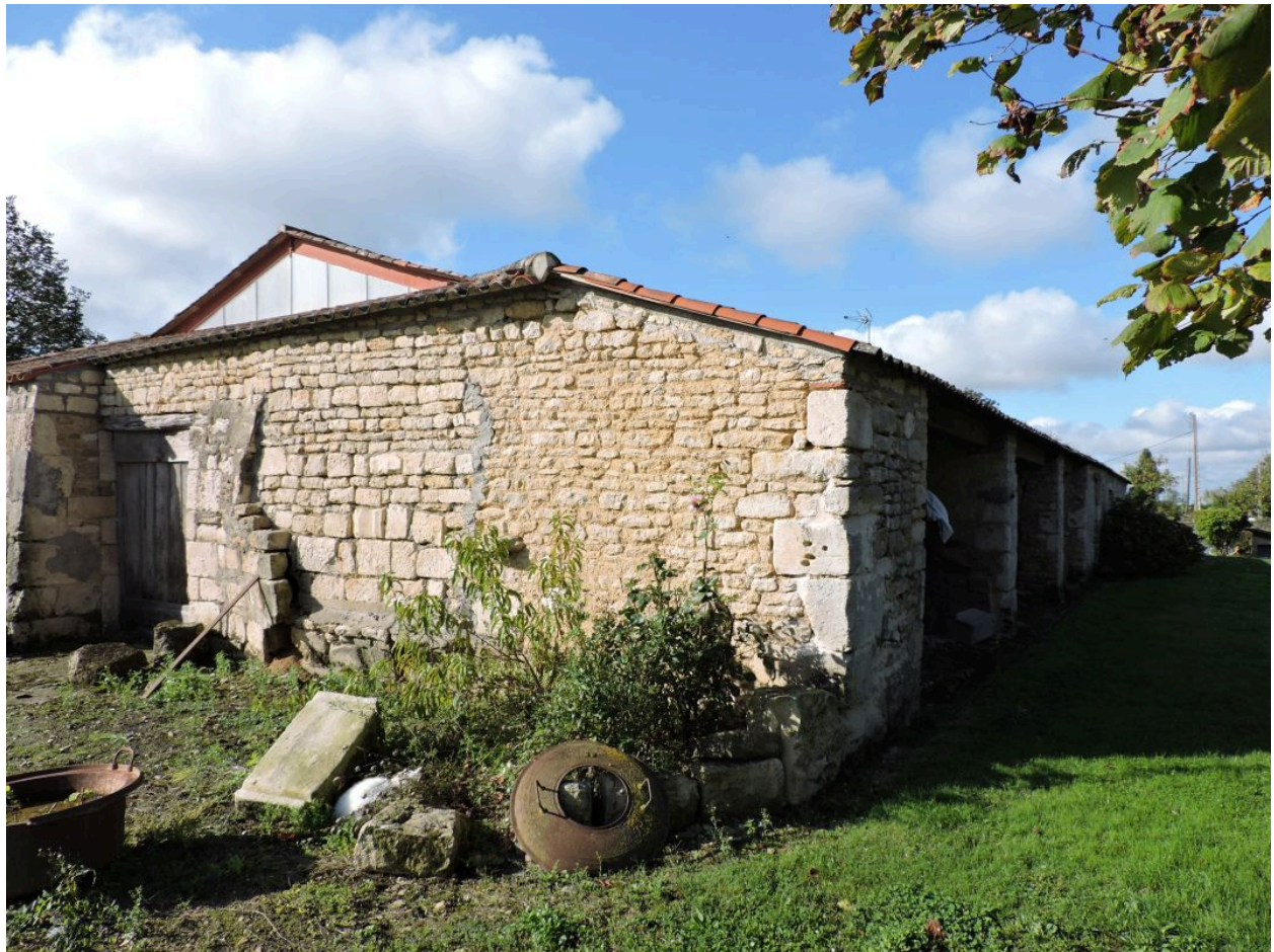
Les dépendances vues depuis le nord-est.
