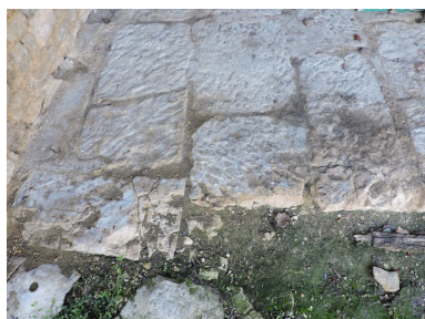
Pavement en gros blocs de pierre de taille dans les dépendances en appentis au nord. Phot. Yannis Suire IVR52_20198503132NUCA
