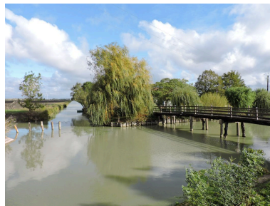
La Grande Cabane et sa passerelle par-dessus le canal de Vix, vues depuis le sud-ouest.
