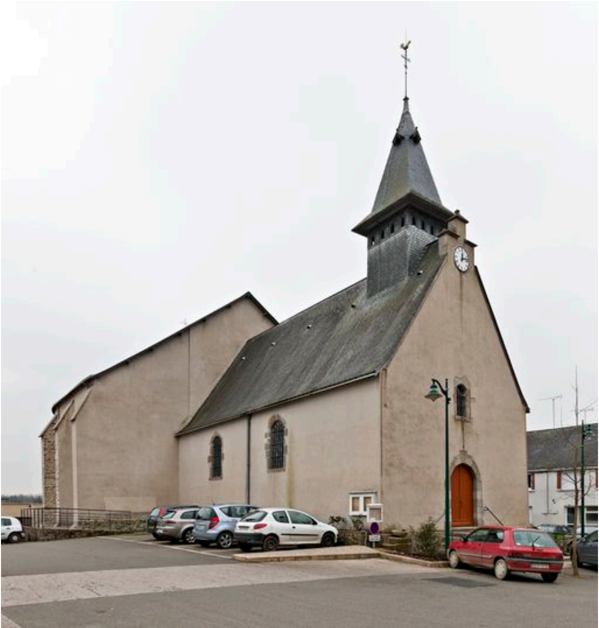
Vue générale des façades ouest et nord de l'église paroissiale de Saint-Jean-sur-Mayenne.
