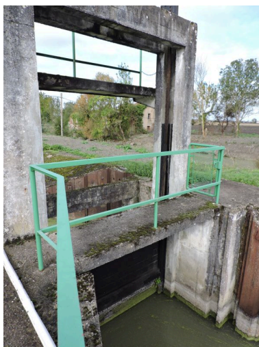
Le pertuis nord avec vanne verticale à crics à crémaillères. Phot. Yannis Suire IVR52_20198503144NUCA
