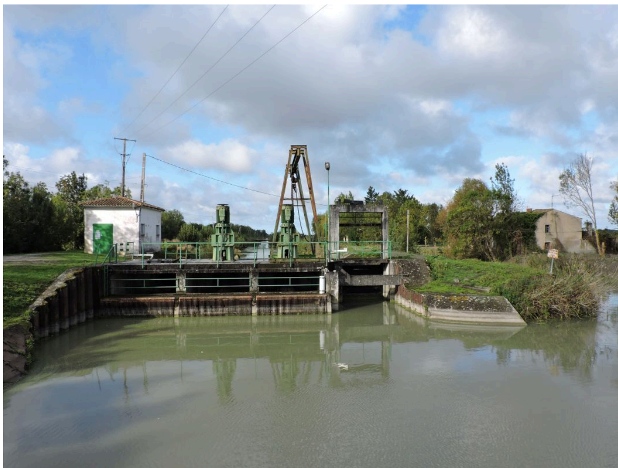
Le barrage vu depuis l'amont, à l'est.
