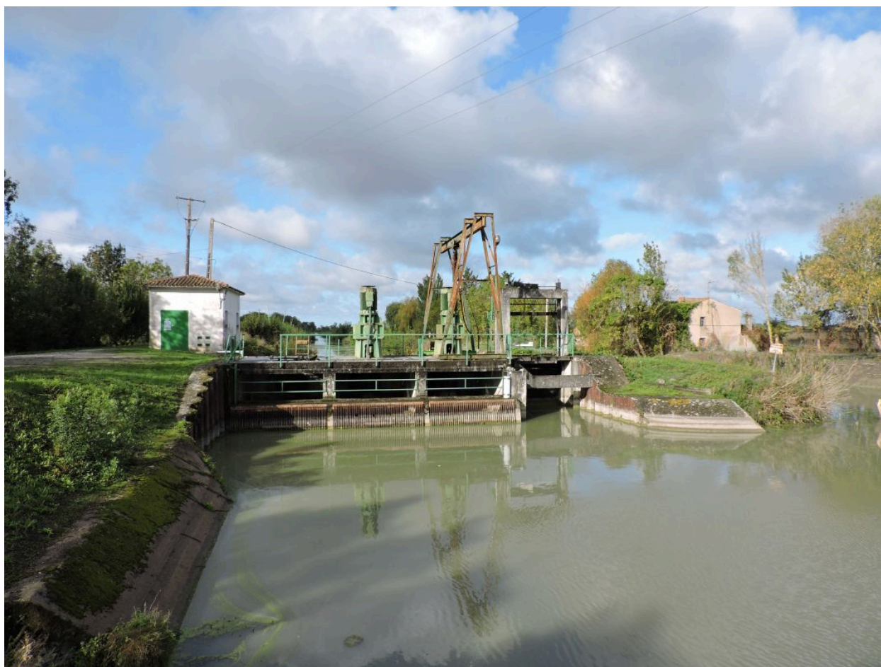
Le barrage vu depuis l'amont, à l'est.
