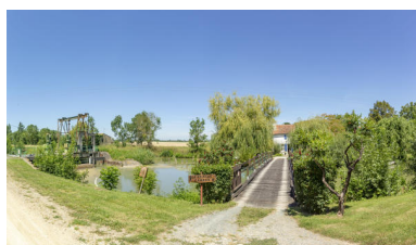
Les pompes de la Grande cabane. Phot. Pierre-Bernard Fourny IVR52_20208501281NUCA
