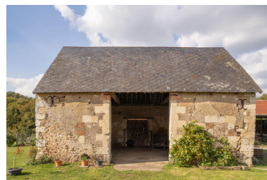
Ancien logis transformé en grange : vue frontale. Phot. Jeanne Minier IVR52_20257200708NUCA
