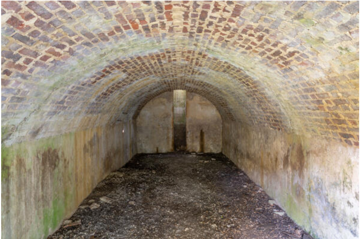
Cellier semi-enterré : intérieur.
