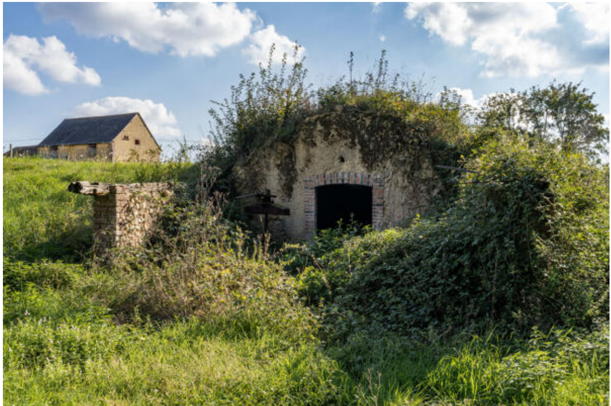
Cellier semi-enterré et pressoir à fruits : vue d'ensemble avec l'étable-fenil en arrière-plan.
