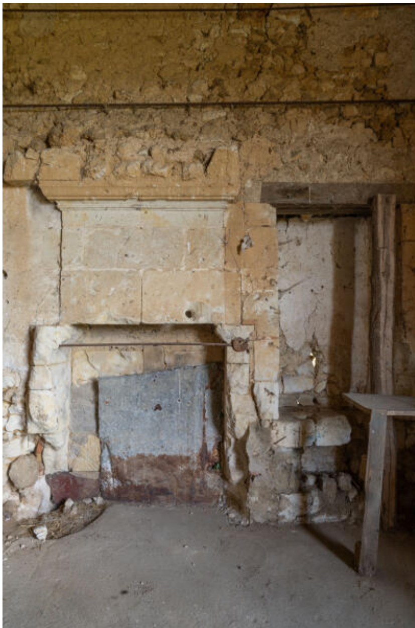
Ancien logis transformé en grange : cheminée, pignon nord.
