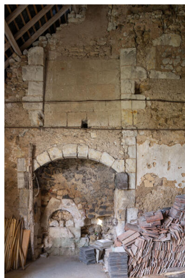
Ancien logis transformé en grange : cheminée, pignon sud. Phot. Jeanne Minier IVR52_20257200711NUCA
