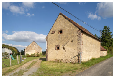
Vue d'ensemble depuis la route. Phot. Jeanne Minier IVR52_20257200703NUCA
