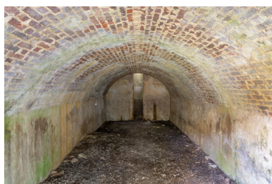
Cellier semi-enterré : intérieur.
