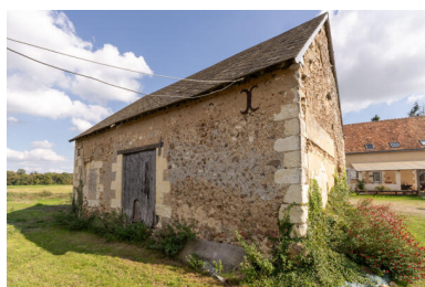
Ancien logis transformé en grange : façade arrière. Phot. Jeanne Minier IVR52_20257200709NUCA
