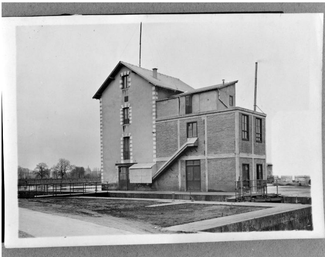
Le moulin vu du sud-ouest, dans le deuxième quart du 20e siècle (?).
