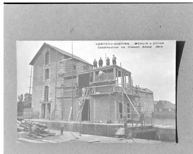
Le moulin vu du sud-ouest lors de la construction de l'extension en béton et en brique, en 1913. Repro. François Lasa IVR52_20025300628X
