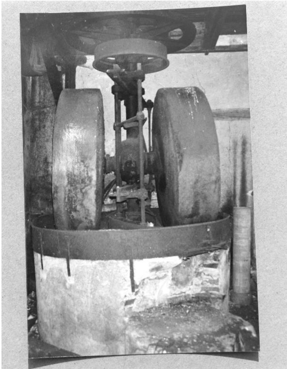
Premier étage du moulin : les meules à huiles avant la destruction du moulin, en 1991.
