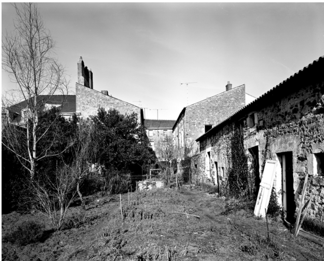
La maison n° 33, vue prise depuis le jardin.
