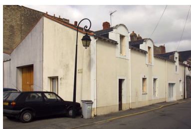
La maison n° 25 rue Pierre-Jubau, les logements en retour sur la rue Pierre-Chevry . Phot. Denis Pillet IVR52_20044401951NUCA
