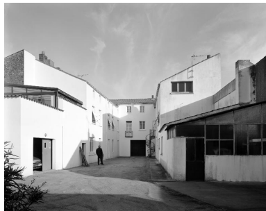
La maison n° 31 rue Pierre-Jubau, vue prise depuis la cour. Phot. François Lasa IVR52_19984400531V
