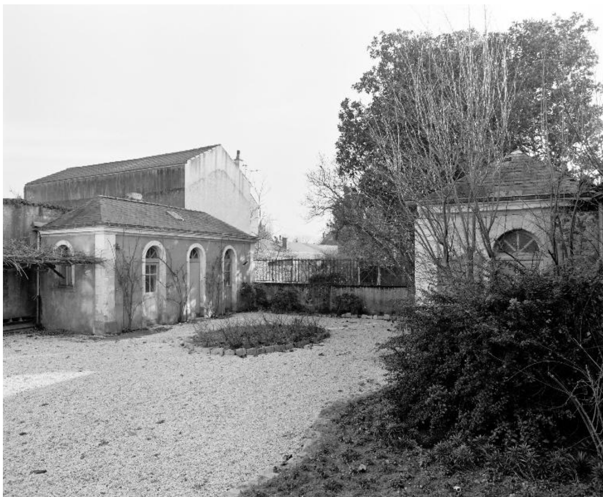
La maison n° 17 rue Pierre-Jubau : les dépendances.
