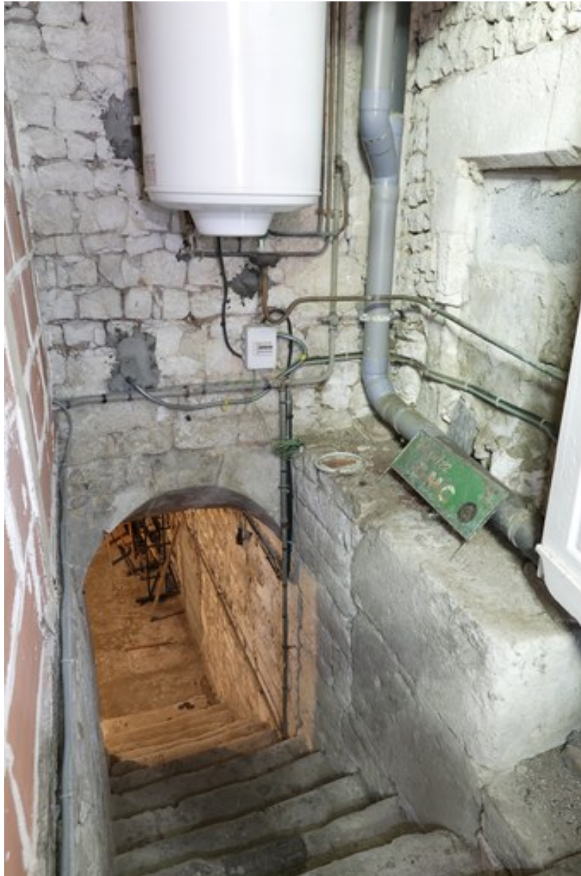
Vue de l'escalier menant à la cave, 10bis rue du Président-de-Gaulle.
