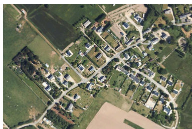
Vue aérienne de l'écart de Kerbenet. IVR52_20084404138NUCA
