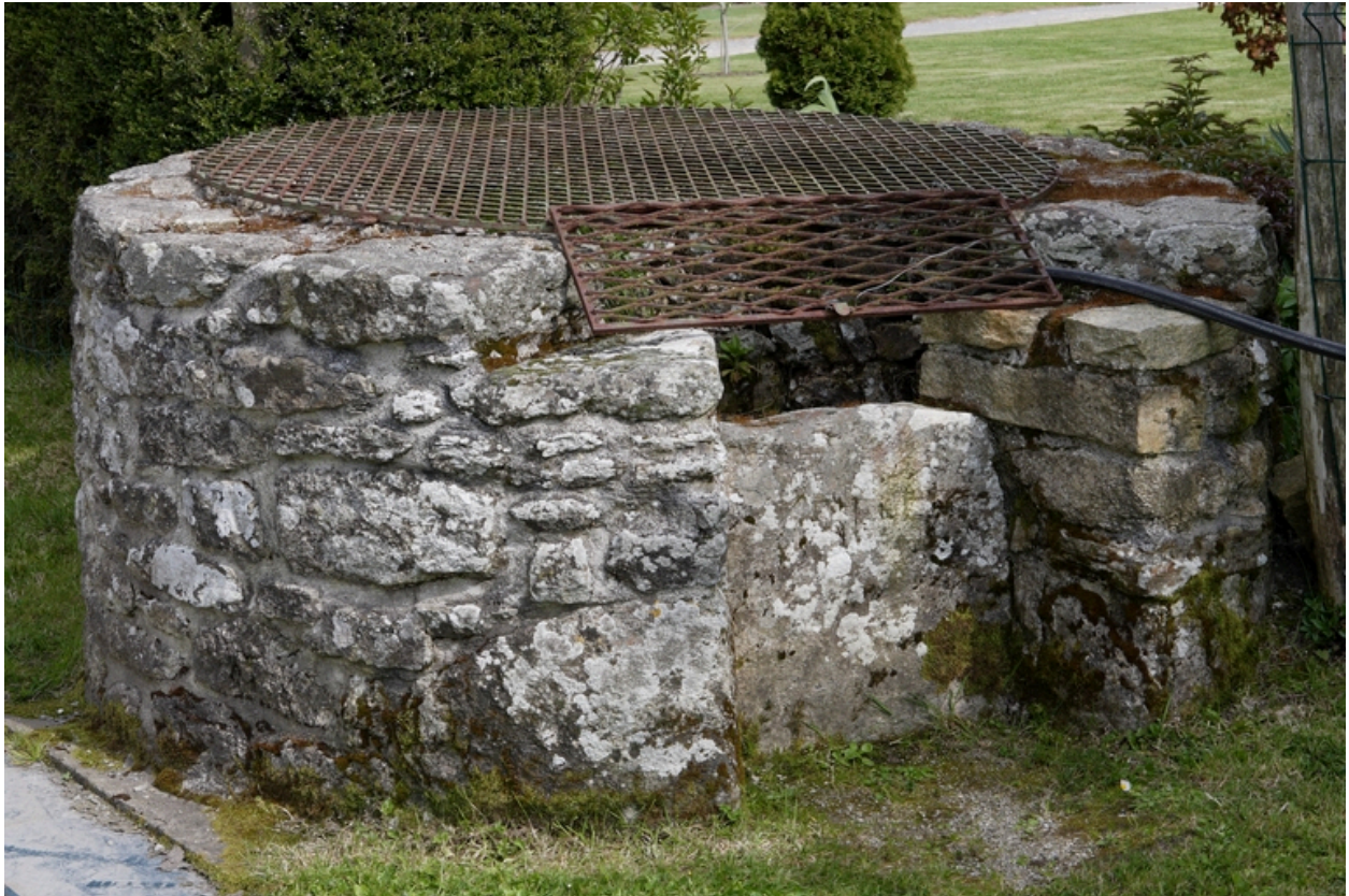
Vue du premier puits.
