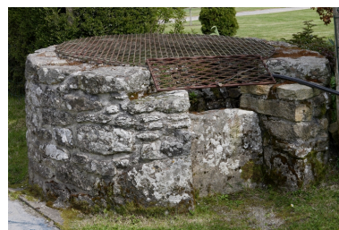
Vue du premier puits. Phot. Denis Pillet IVR52_20084401444NUCA
