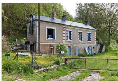
Maison construite à la naissance du coteau, façade sud. Phot. Yves Guillotin IVR52_20127200965NUCA
