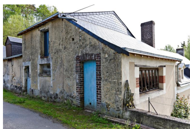
Ancienne meunerie. Phot. Yves Guillotin IVR52_20127200963NUCA
